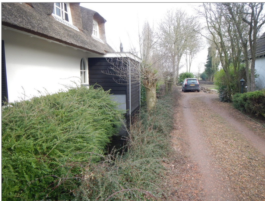
Afb. 7 Foto van boorlocatie 2, genomen in noordelijke richting
