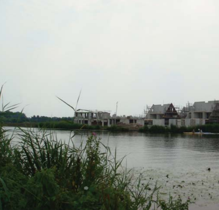
▲ woonwijk in aanbouw aan de overzijde Alblas
