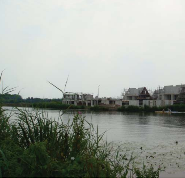
▲ woonwijk in aanbouw aan de overzijde Alblas
