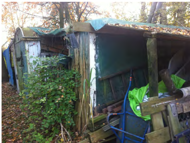
Zicht op bestaande bijgebouwen;
