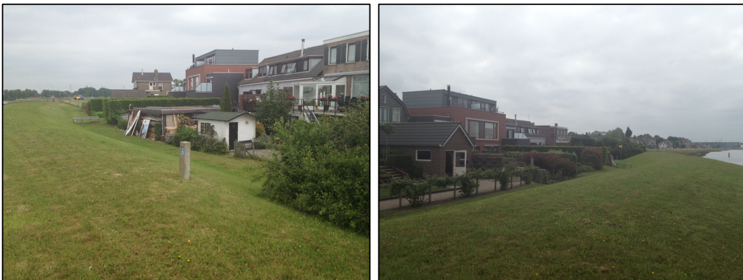
Situatie achterzijde woningen OK 48-66
