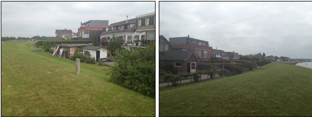
Situatie achterzijde woningen OK 48-66
