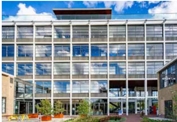
industriële architectuur open betonstructuur
