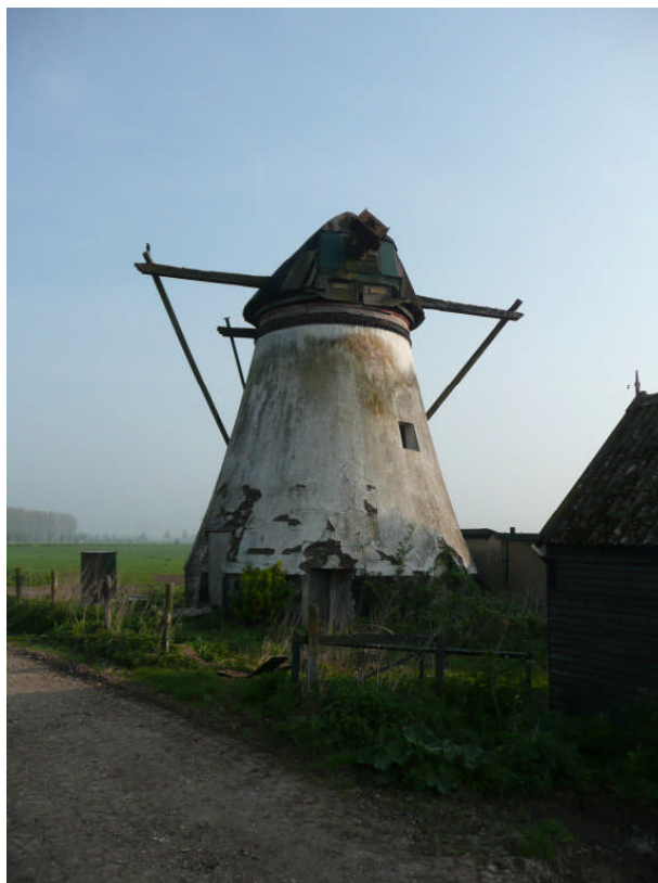
Fig. 1: De vervallen poldermolen in Polder Souburgh (foto: Vestigia).
