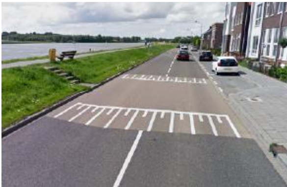
Figuur 4.6: drempelvlak aanbrengen.
