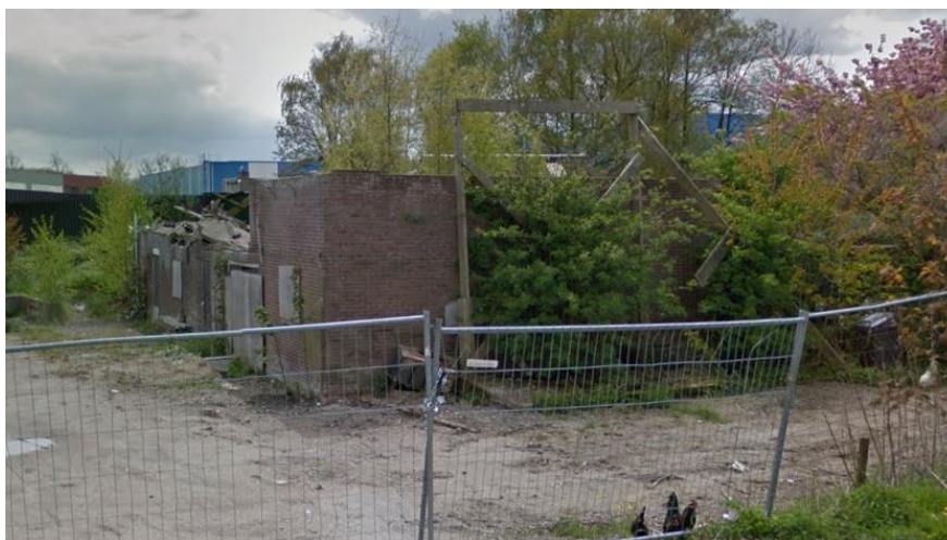
Afbeelding 5: Ingestorte voormalige agrarische schuur
