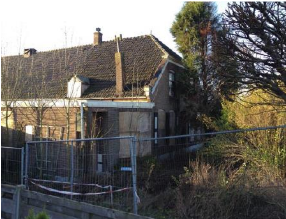
Afbeelding 4: Bestaande boerderijgebouw Vinkenspolderweg 1 (voor brand)
