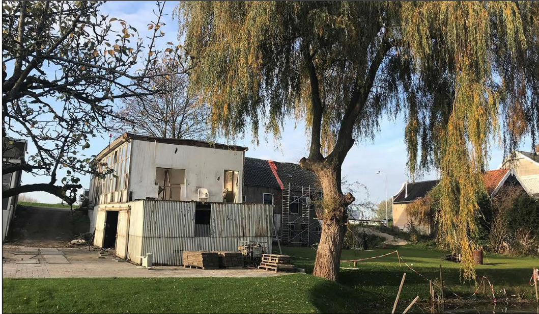
Figuur 2: Foto bestaand bedrijfspand, gezien vanaf benedendijks (bron: Van der Padt & Partners Architecten)
