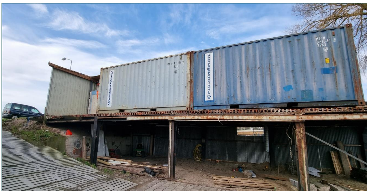
Figuur 2 De containerschuur is reeds grotendeels gesaneerd, er zijn enkel 2 containers over en het originele frame.
