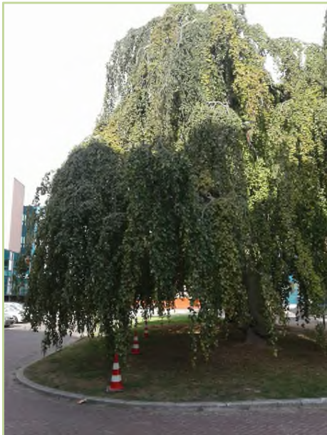
De pionnen geven de insteek van de parkeergarage aan bij boom 2.
