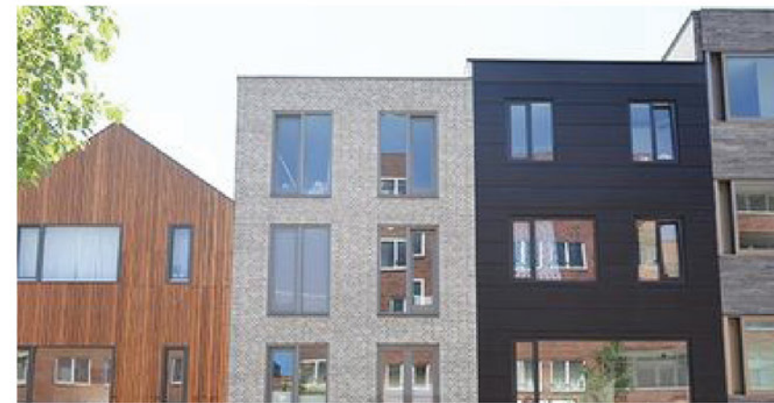
Verschillende dakvormen schouder aan schouder
