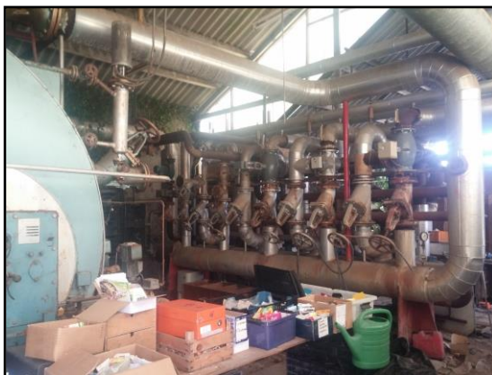
Foto 3: Ketelhuis aan de Oudendijk
