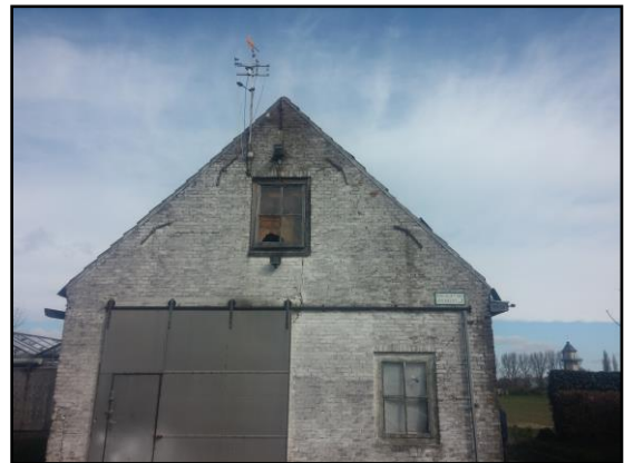
Foto 2: Oude, bakstenen schuur aan Oudendijk
