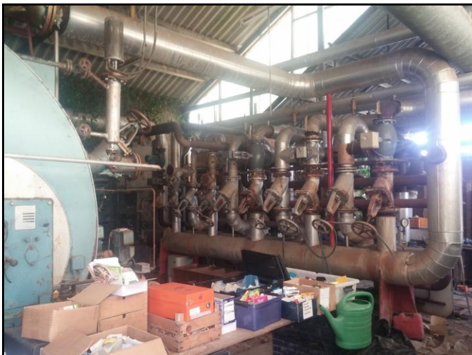
Foto 2: Ketelhuis aan de Oudendijk.
