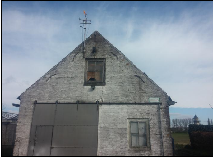
Foto 1: Oude bakstenen schuur aan de Oudendijk.
