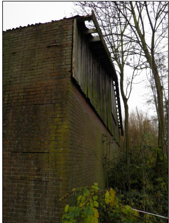
Figuur 5. De houten betimmering langs de muur vormt een potentiële verblijfplaats voor vleermuizen.
