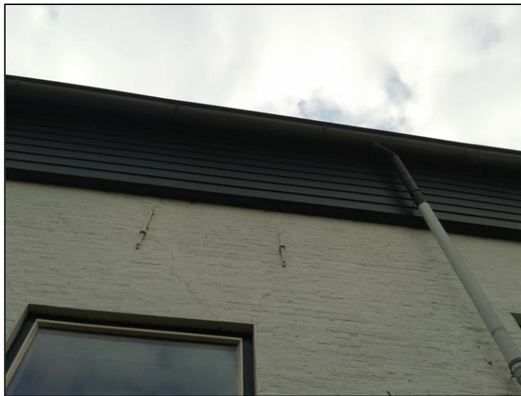
Foto 5: Gevelbetimmering aan het woonhuis
