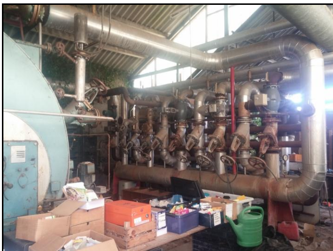
Foto 2: Ketelhuis aan de Oudendijk.
