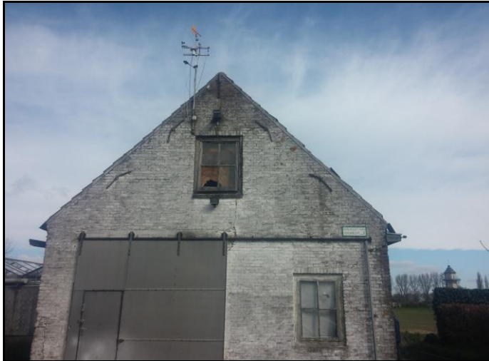
Foto 1: Oude bakstenen schuur aan de Oudendijk.
