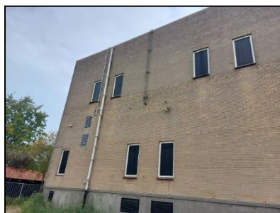
Figuur 2.3 De zuidwestelijk georiënteerde gevel van het hoofdgebouw op de onderzoekslocatie.
