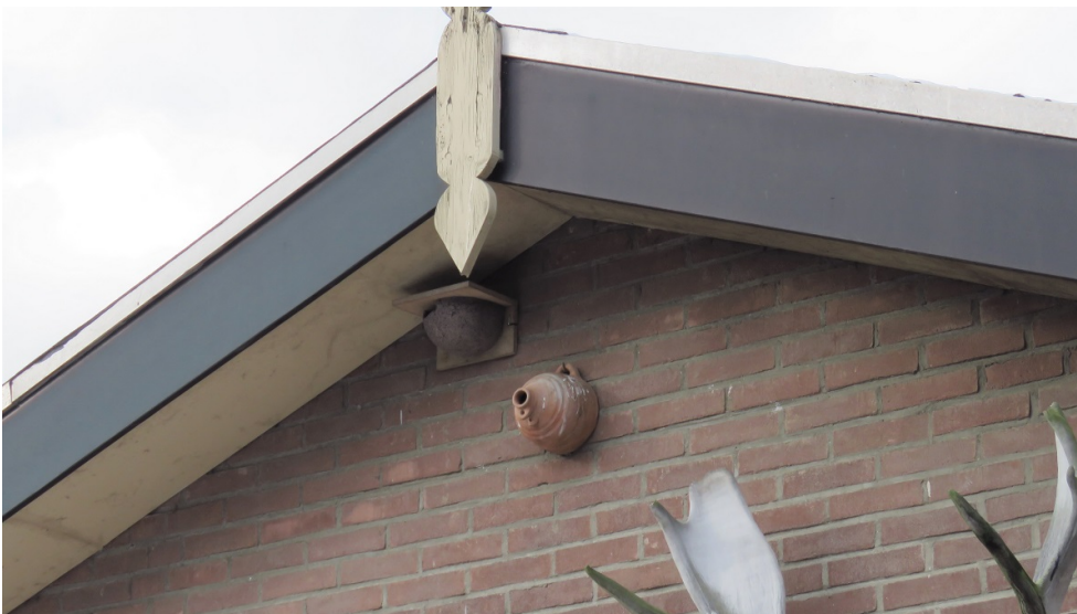
Afbeelding 9: Nestkastjes aan de te slopen bebouwing dienen voorafgaand aan de sloop - buiten het broedseizoen - verwijderd te worden.
