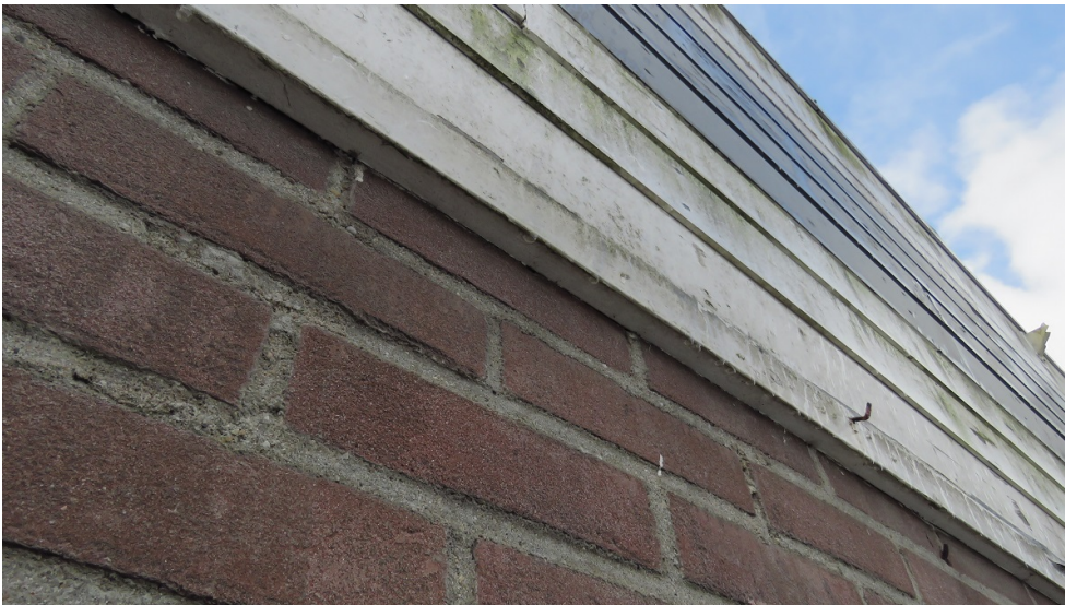
Afbeelding 10: Gevelbeplating sluit naadloos aan op de bakstenen, hier is geen potentie voor vleermuis verblijfplaatsen.
