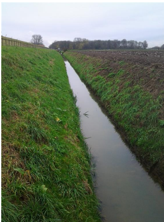
Foto 14: Watergang Buitendijk t.h.v. DWP 39
