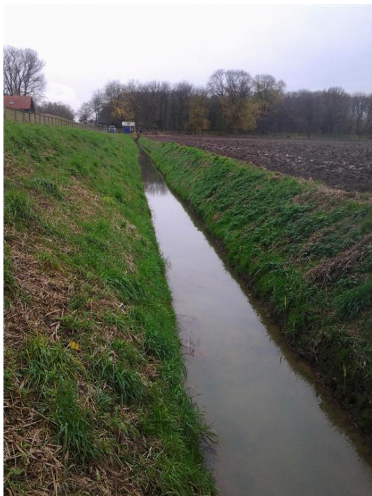
Foto 15: Watergang Buitendijk t.h.v. DWP 42
