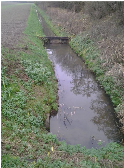
Foto 16: Watergang Buitendijk t.h.v. DWP 44
