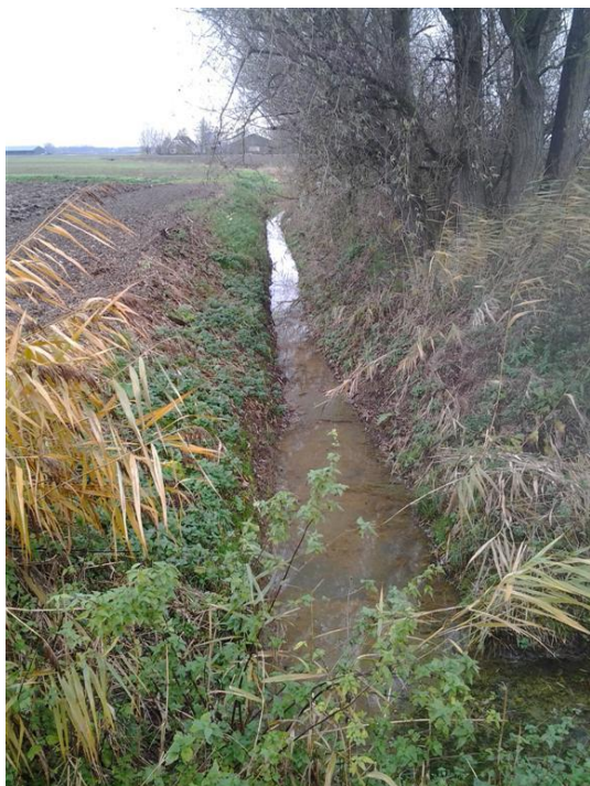
Foto 13: Watergang Buitendijk t.h.v. DWP 36
