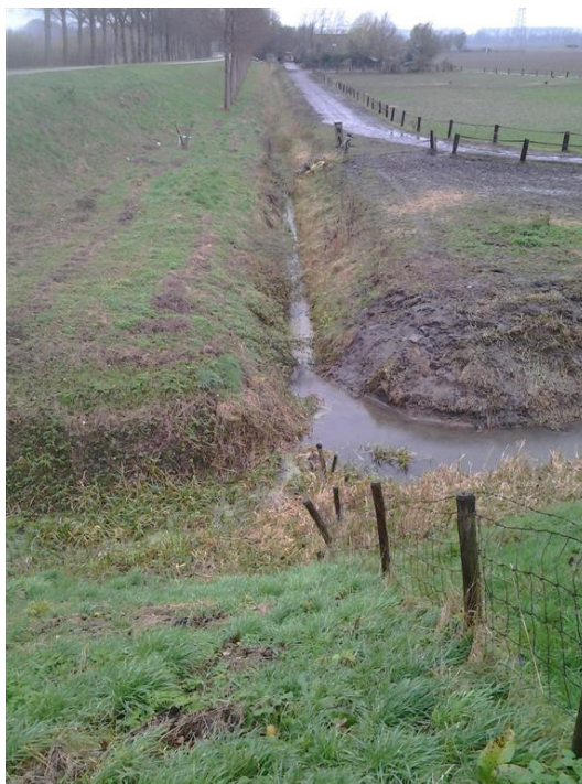
Foto 10: Watergang Zeedijk t.h.v. DWP 27
