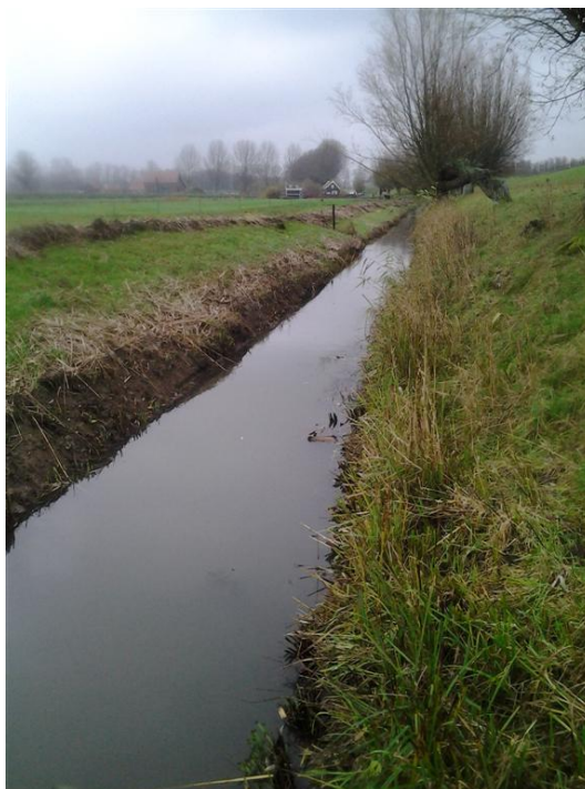
Foto 12: Watergang Zeedijk t.h.v. DWP 31
