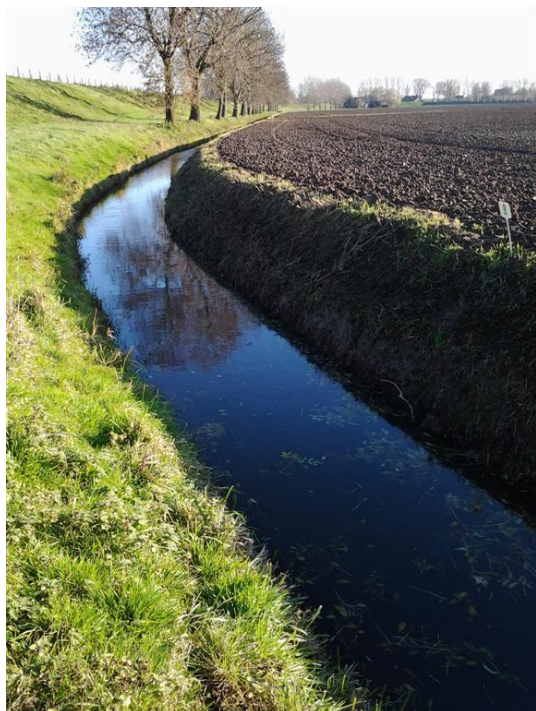
Foto 7: Watergang Zeedijk t.h.v. DWP 19
