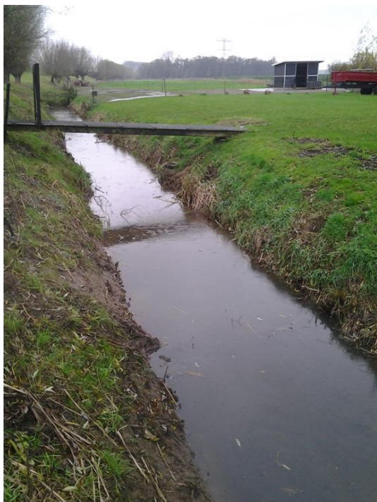
Foto 11: Watergang Zeedijk t.h.v. DWP 29
