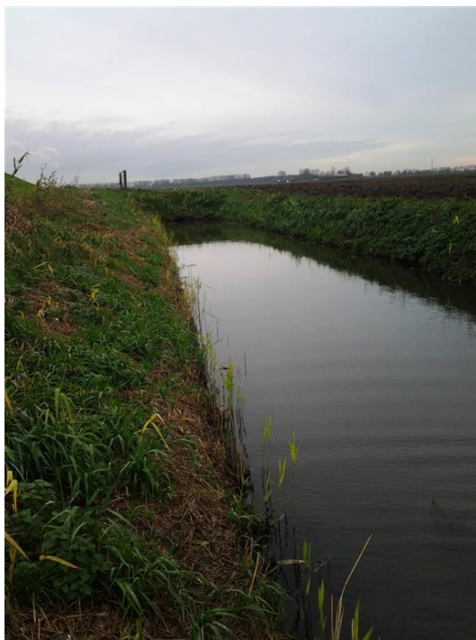
Foto 18: Watergang Buitendijk t.h.v. DWP 49
