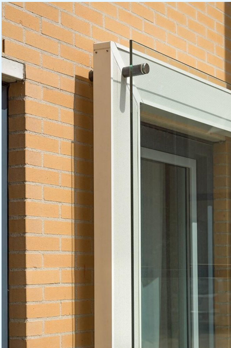
figuur 6: voorbeeld voorzetraam voor creëren geluidluwe zijde (bron: www.metaglas.nl )
