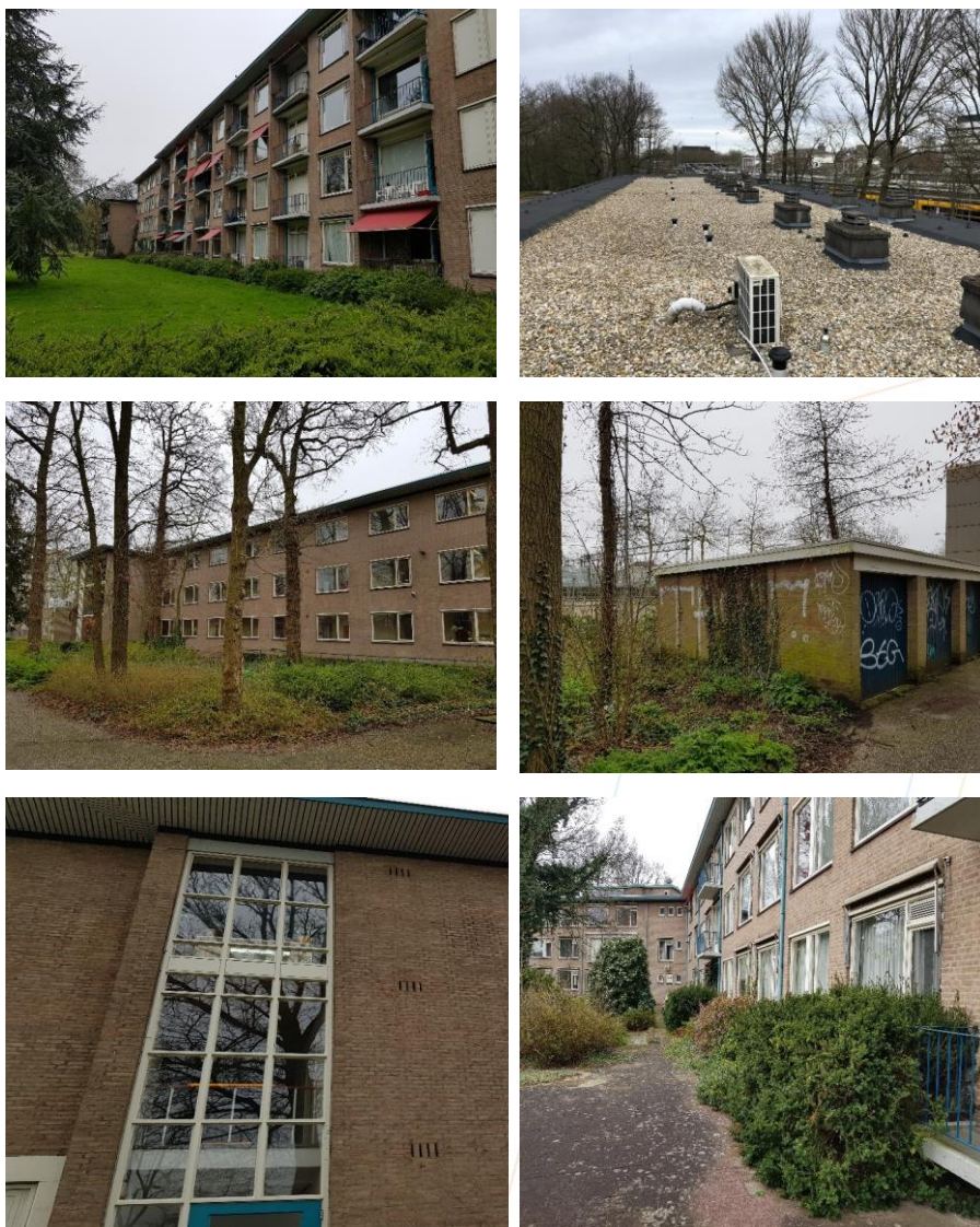
Figuur 2-3. Huidige situatie plangebied, met linksboven één van de hogere vleugels van het complex, rechtsboven een impressie van een van de daken, linksmidden het complex ten opzichte van omliggend groen, rechtsmidden een losliggende garage. Linksonder een detailfoto van gevel en daklijsten, rechtsonder een impressie van de begroeiing langs de gevels.
