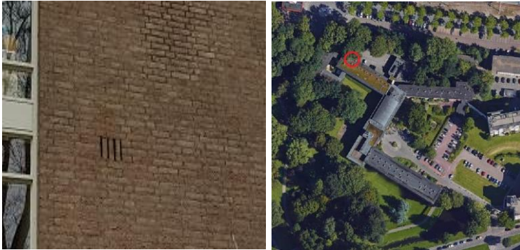
Figuur 4-2. Links het betreffende ventilatierooster, waar pimpelmezen een nest bouwen, rechts de locatie van het nest in aanbouw in het plangebied, gemarkeerd met een rode cirkel, bron: Google maps.
