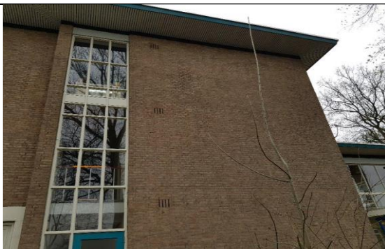
Ventilatie roosters in de gevel
