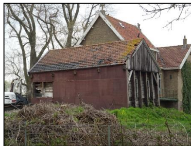
Figuur 4. Schuur aan de westzijde van de onderzoekslocatie.
