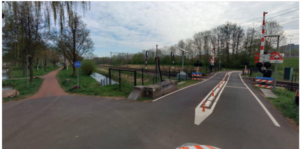
Figuur 5 Aansluitend fietspad (links op de foto) aan de westzijde van de overweg.
