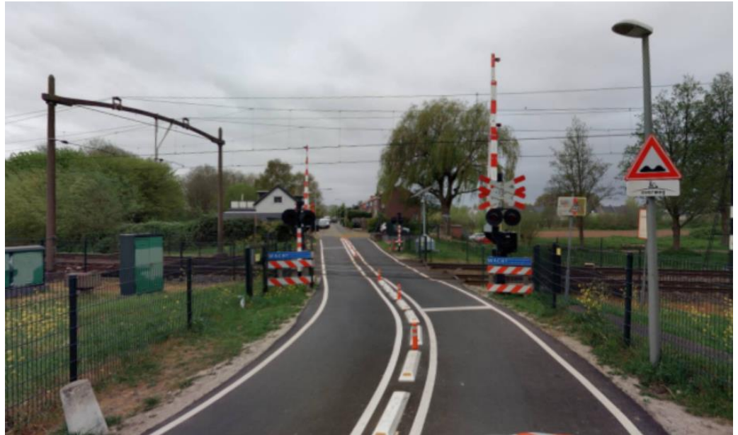
Figuur 3 Zicht op overweg Zuidendijk in westelijke rijrichting.
