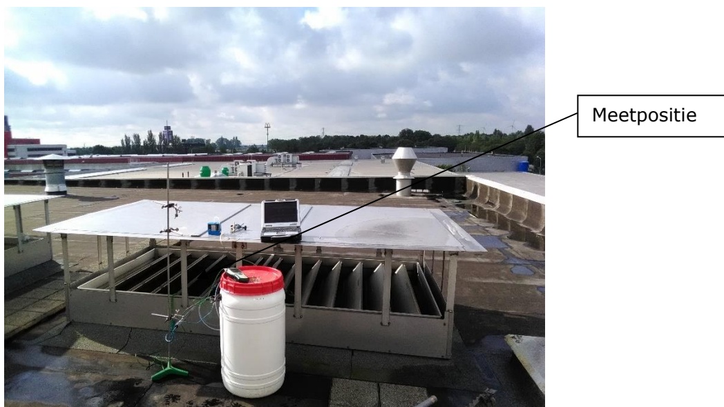
Figuur 2.7 Foto van de meetsituatie van de ruimteventilatie branderij
