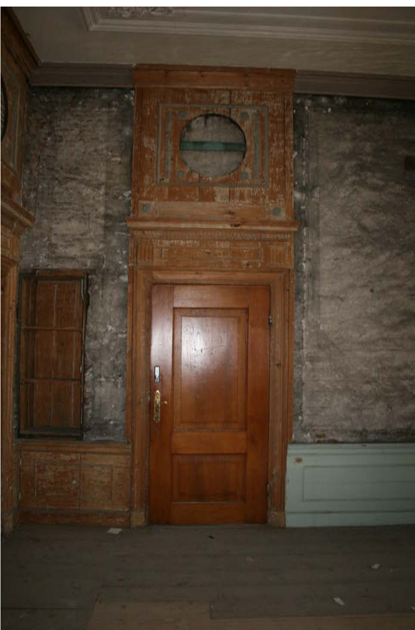
RUIMTE 0.101 - ENTREE DEUR
