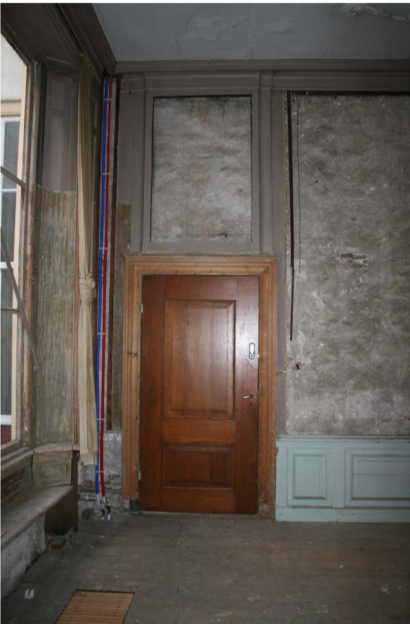
RUIMTE 0.104 - ENTREE DEUR
