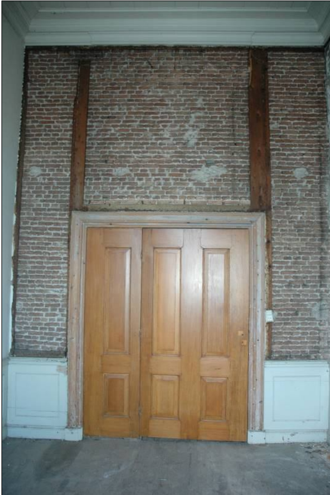
Afb. 21: Ruimte 0.08. Vanwege een muur die haaks aansluit op het linker gedeelte kan slechts twee- derde van deze deur open.
