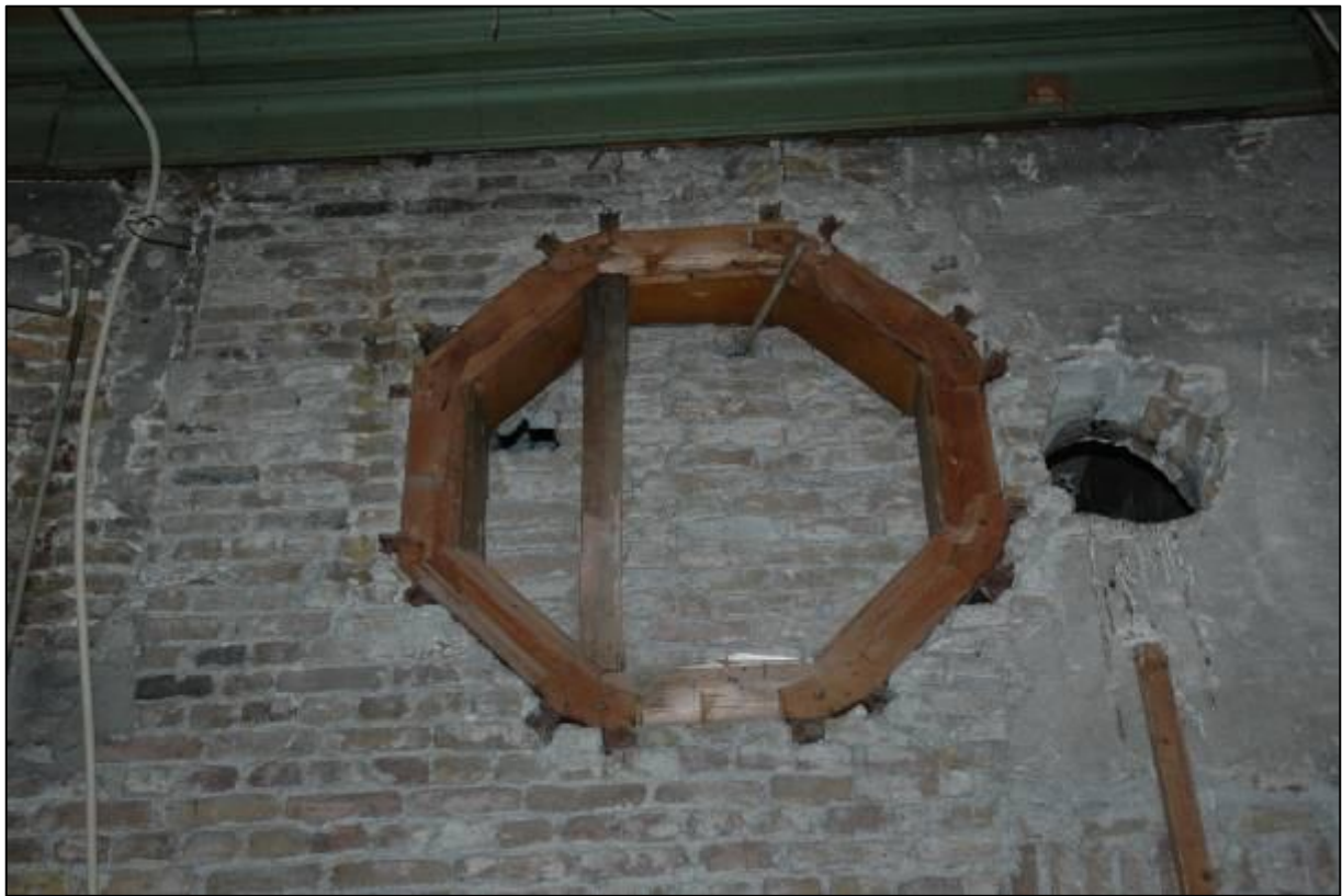
Afb. 27: Ruimte 0.15, het midden van de achterwand. Deze achthoekige 'nis' heeft een onbekende oorsprong, maar zou samen kunnen hangen met de trap die hierboven van links naar rechts tussen de eerste verdieping en de zolder liep. Werd hier door een oculus licht gegeven aan een achterliggend hoog vertrekje? Werd de opening in latere instantie opgevuld, tot een verdiept vlak? Jammer genoeg ontbreekt heden ten dage de aankleding die wellicht zou kunnen helpen deze vragen te beantwoorden.
