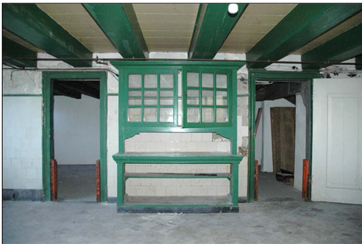
Afb. 8: Ruimte -1.01 naar rechts, met de doorgangen naar de kleine ruimtes. Deur en kozijn van de voorste ruimte (-1.02, rechts op de foto) behoren tot de oudste onderdelen van de kelder of het onderhuis. Zij zouden kunnen terug gaan op een versie van de kelder die voorafging aan de huidige, die 19de-eeuws lijkt.
