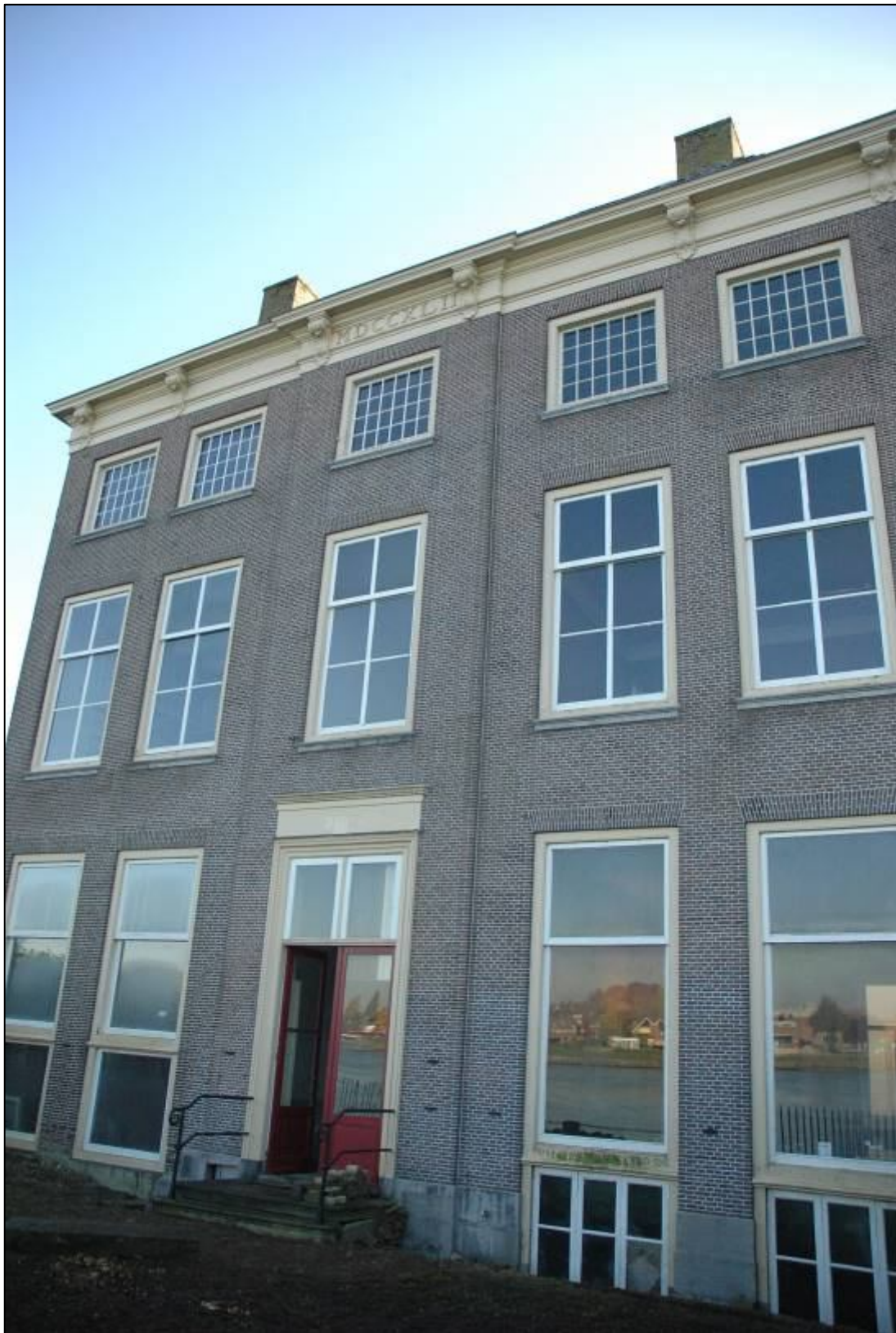
Afb. 5: De achtergevel, een 'vijfasser' met vensters uit zeer uiteenlopende periodes. Linksonder was in het laatste kwart van de 20ste eeuw een doorlopende pui aangebracht. De wijze waarop rechts de souterrainvensters op die van de bel-etage aansluiten is het gevolg van wat eerdere ingrepen.
