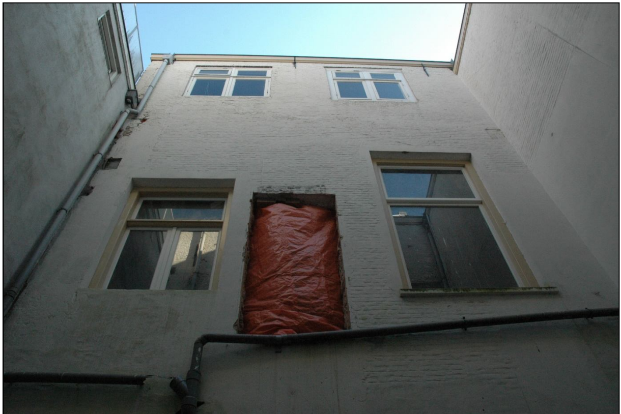
Afb. 25: (Buiten)ruimte 0.11, de eerste en tweede verdieping gezien naar voor. Deze drie wandopeningen zijn gezamenlijk te zien op de bouwtekening uit 1908. De vensters links en rechts waren voordien al in een andere vorm aanwezig. De detaillering, met name aan de binnenkant zichtbaar, wijst uit dat het rechtse van de twee het meest van zijn 19de-eeuwse vorm behield. Geheel boven is het rechtse van de twee vensters met draairamen het exemplaar met onderdelen van een ouder (kruis)venster.
