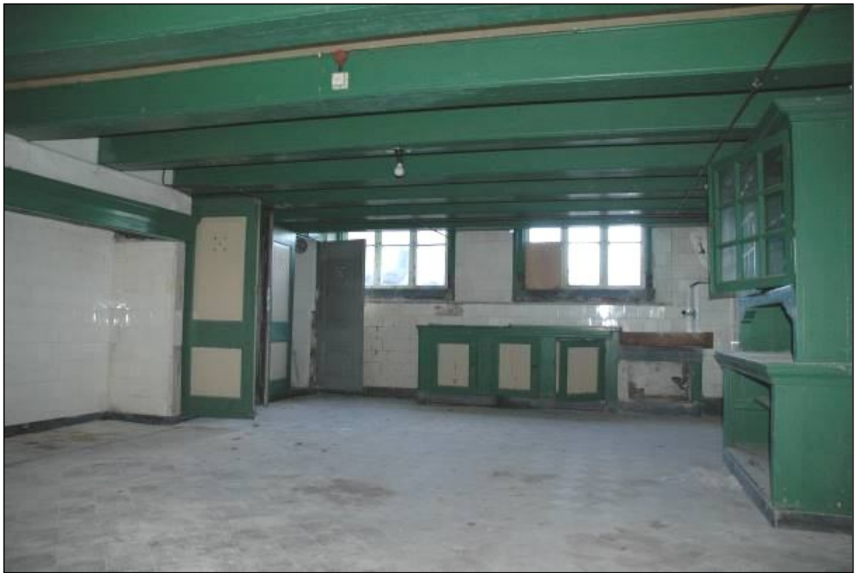
Afb. 7: Ruimte -1.01. De grote kelderruimte linksachter, gezien naar achter. De opzet zal uit de 18de eeuw stammen, maar in de aankleding zien we ook veel 19de-eeuwse elementen. De zesdelige ramen in de voor- en achtervensters zijn van nog latere datum, zie ook afb. 5.
