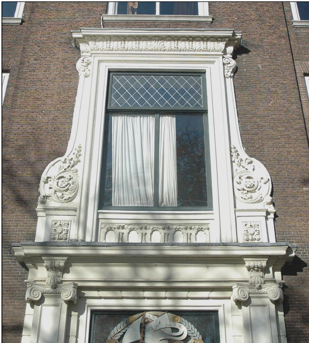
Afb. 48: De middenrisaliet van de voorgevel ter hoogte van de eerste verdieping. Vergelijk de ornamentiek met de 18de-eeuwse weergave door Schouman (afb. 47).
