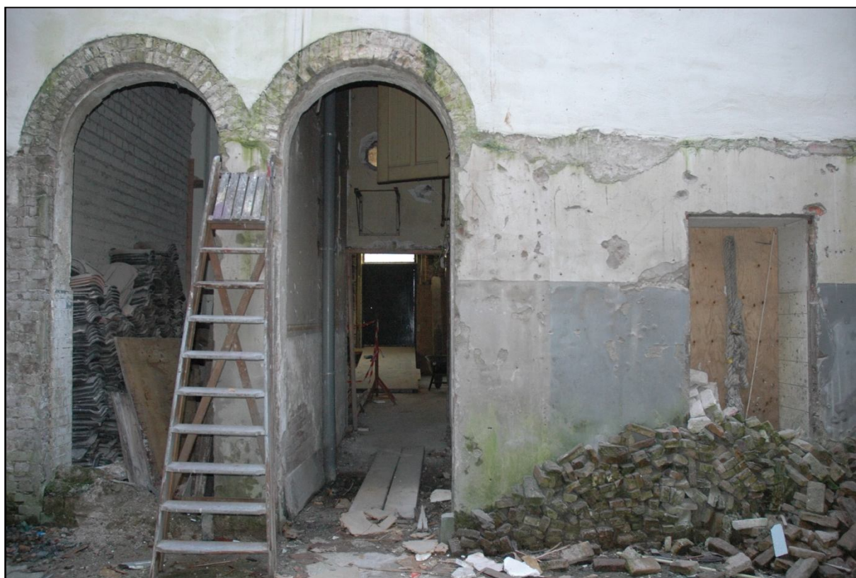
Afb. 24: (Buiten)ruimte 0.11. We zien de voorwand van de binnenplaats rechts in het bouwblok, naar voor. De rondgesloten opening links op de foto leidt naar een onbestemd smal gangetje, maar links daarvan was een verbinding naar het oostelijke buurpand te vinden. Dat maken de kalkzandsteen metselstenen ook inzichtelijk: hier werd wat dichtgezet. Op de bouwtekening uit 1894 is zichtbaar dat zich in die kleine travee een trap bevonden heeft, bereikbaar vanuit het voorvertrek (ruimte 0.15).
