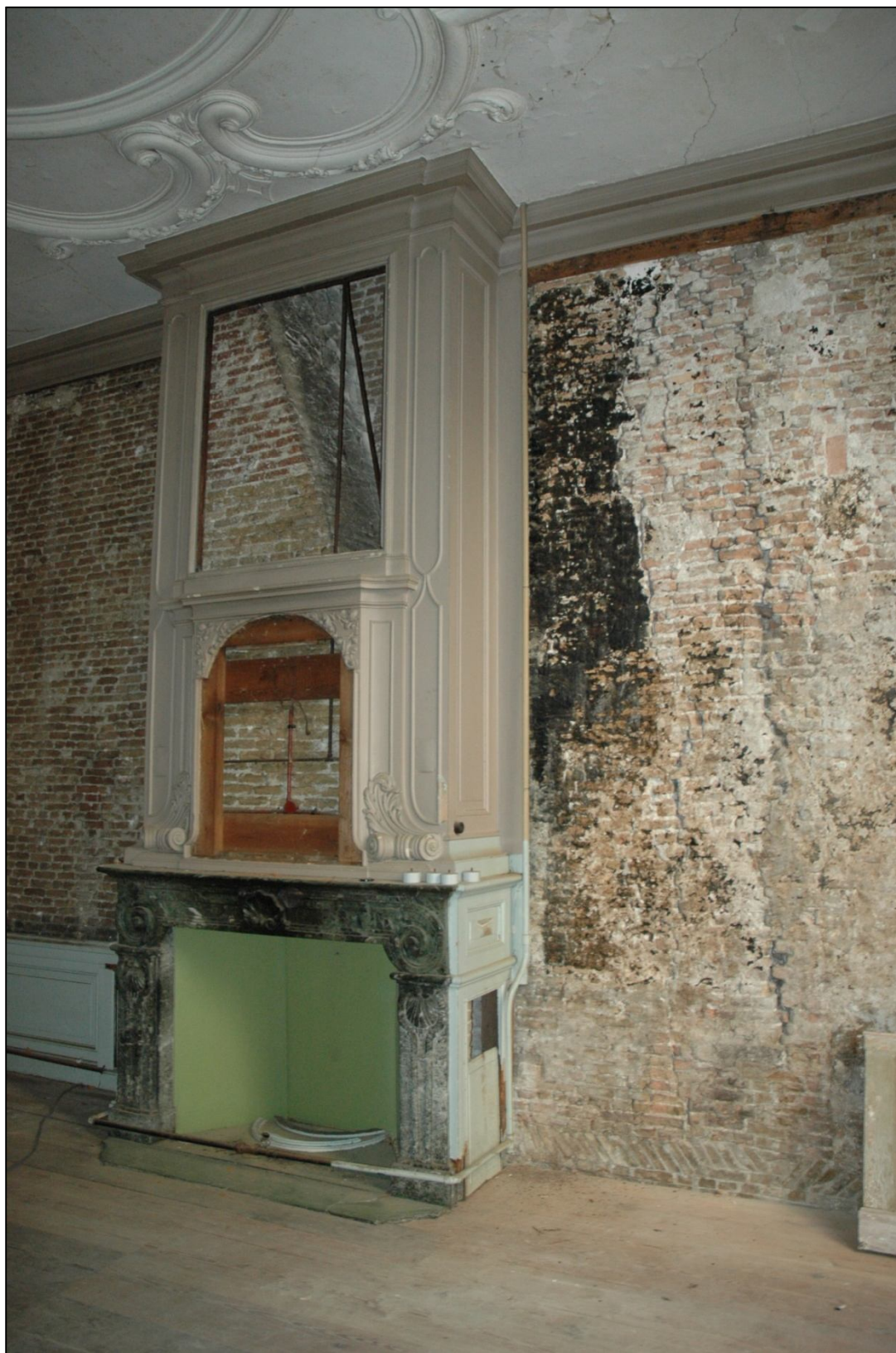
Afb. 14: Ruimte 0.03. Merk op dat het metselwerk rechts van de schouw ouder oogt. Daar bevindt zich ook een roetbaan van een eerdere stookplaats. De stroomlaag eronder leidt tot de vraag wat is wegge- werkt.
