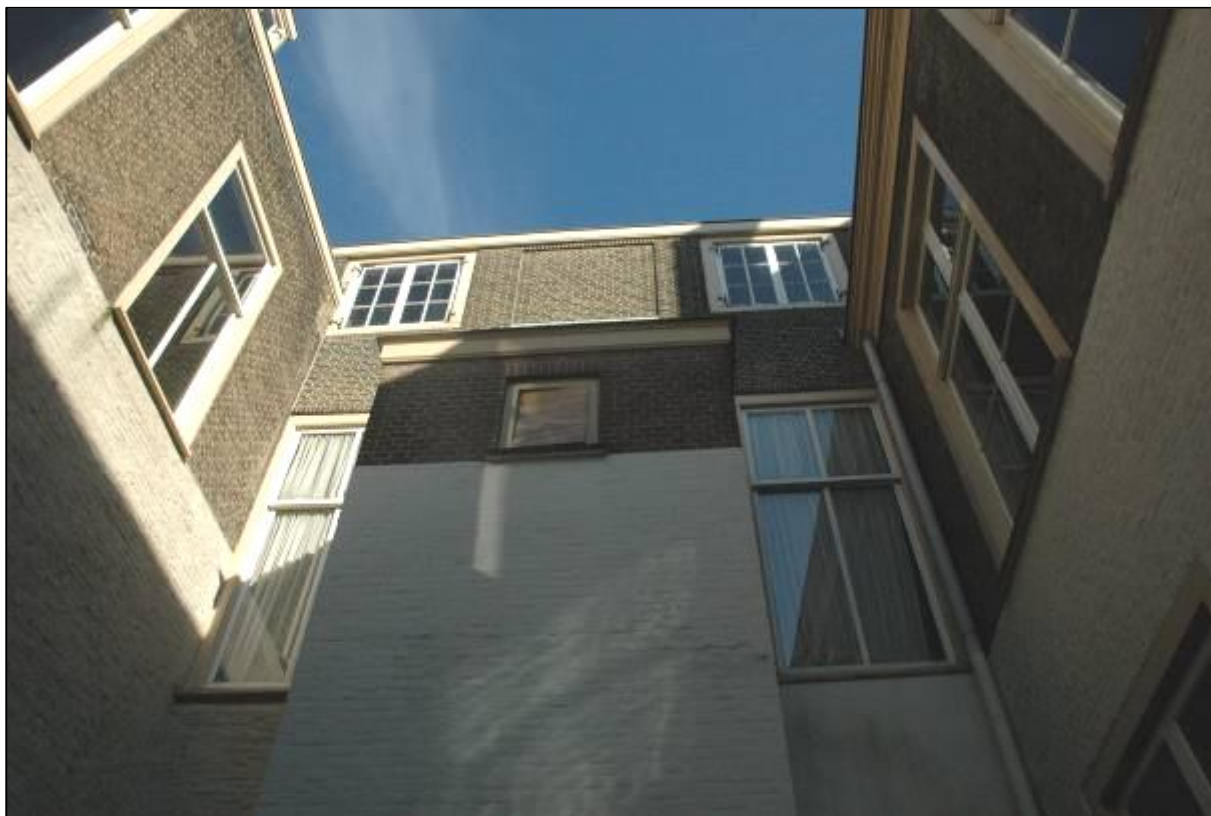
Afb. 16: Buitenruimte 0.04, de linker binnenplaats.
