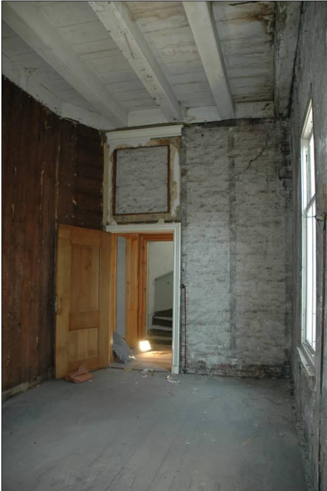
Afb. 33: Ruimte 1.07 naar het midden gezien. We zien onder meer forse balken die bij de 18de-eeuwse opzet van het achterhuis links kunnen horen.
