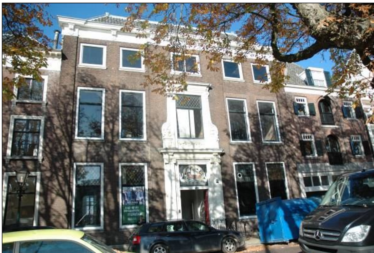
Afb. 4: De voorgevel: vijf vensterassen met oude kozijnen en met ramen en glas uit diverse periodes. Het metselwerk stamt voor een belangrijk deel uit de 18de eeuw, al zijn daarvan ook zones vernieuwd. De gedecoreerde middenpartij blijkt een combinatie van 18de- en 19de-eeuwse onderdelen.
