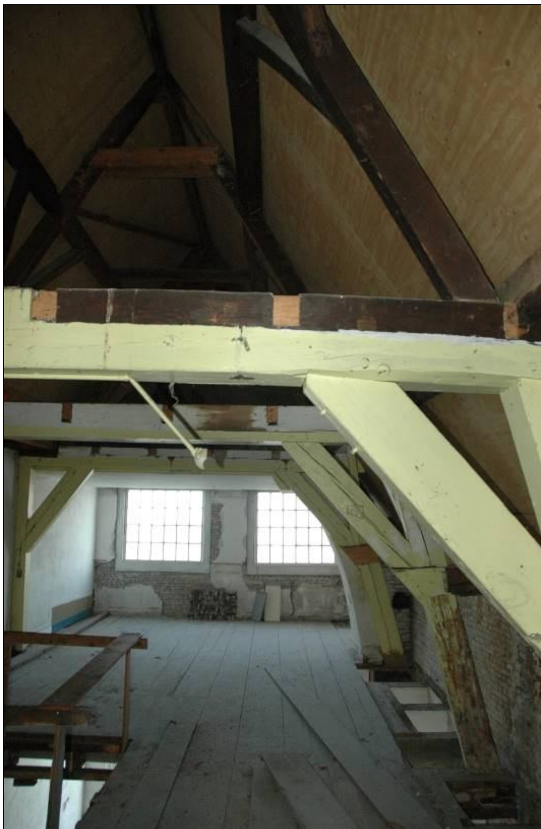
Afb. 44: Ruimte 2.08, de zolder van het achterhuis rechts, richting achterzijde.
