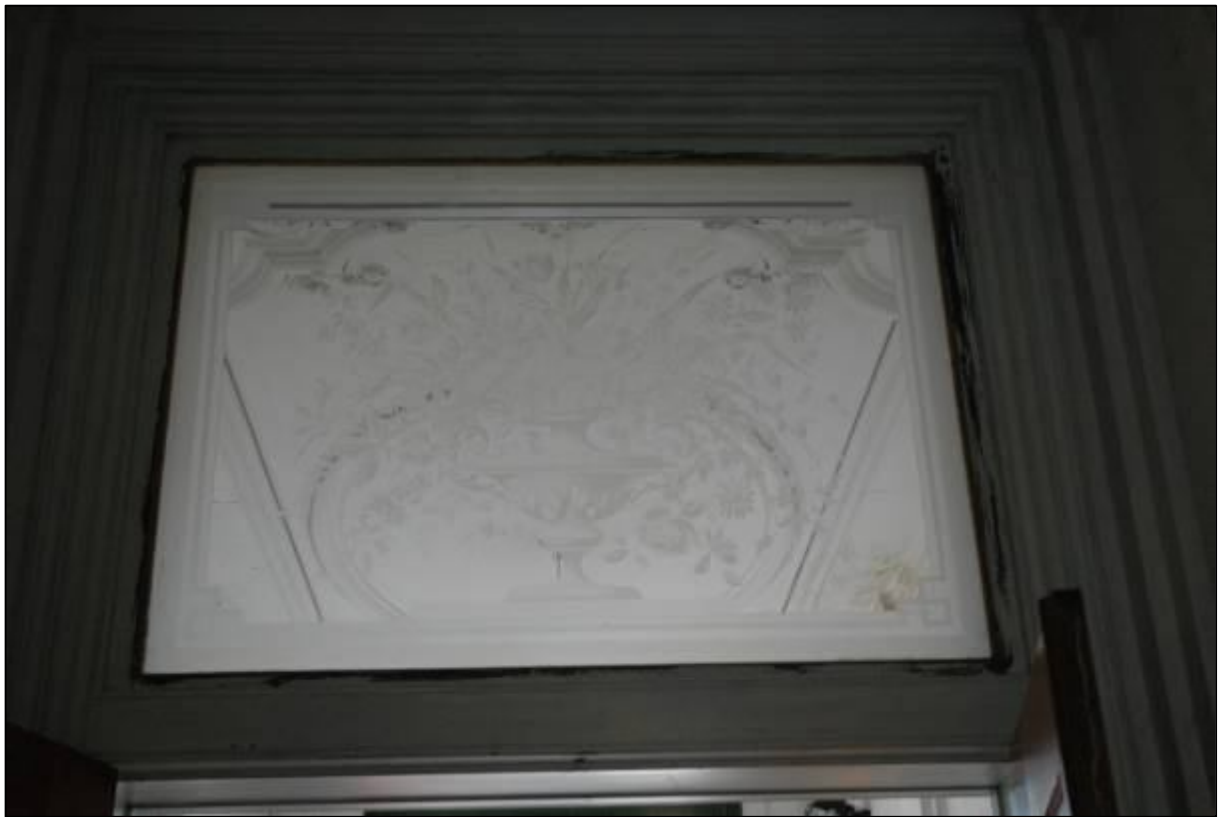
Afb. 11: Ruimte 0.01; geëtst glas in het bovenlicht vooraan de gang.
