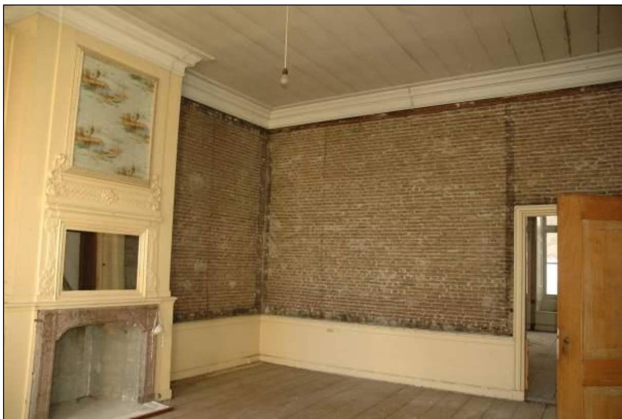
Afb. 30: Ruimte 1.02, het vertrek linksvoor. Schouwmantel en boezem tegen de linker bouwmuur bezitten beide een wat vlakke 'neo'-vormgeving. Ter plaatse van waar een geschilderd schouwstuk had moeten zitten vinden we recent behang.
