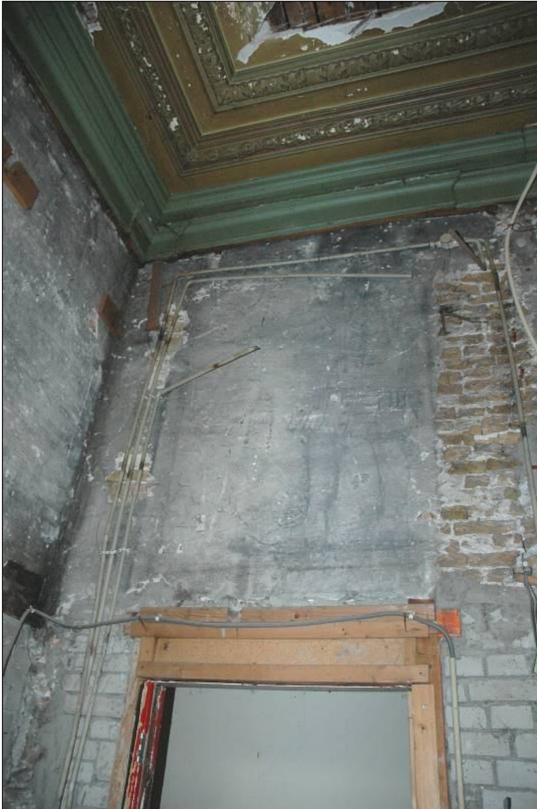
Afb. 26: Ruimte 0.15. De opmerkelijke schets boven de deur links in de achterwand die een oudhollandse figuur voorstelt. Kennelijk diende hij als voorbeeld voor een uitgewerkte decoratie ter plaatse. De deur die er nu zit is zowel qua kozijnhout als omgevend metselwerk 20ste-eeuws. Het is de tekening die verduidelijkt dat hier sinds lang een doorgang is. De bouwtekeningen bevestigen dat.
