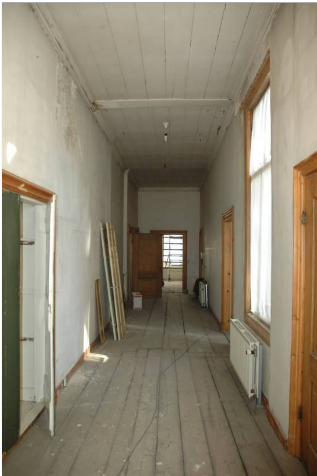
Afb. 28: Ruimte 1.00, de middengang op de verdieping naar voor. De overgang in de vloer doet vermoeden dat er constructief sprake is van een cesuur. De balken die dit zouden kunnen onderbouwen of ontcrachten zijn niet in het zicht gekomen.
