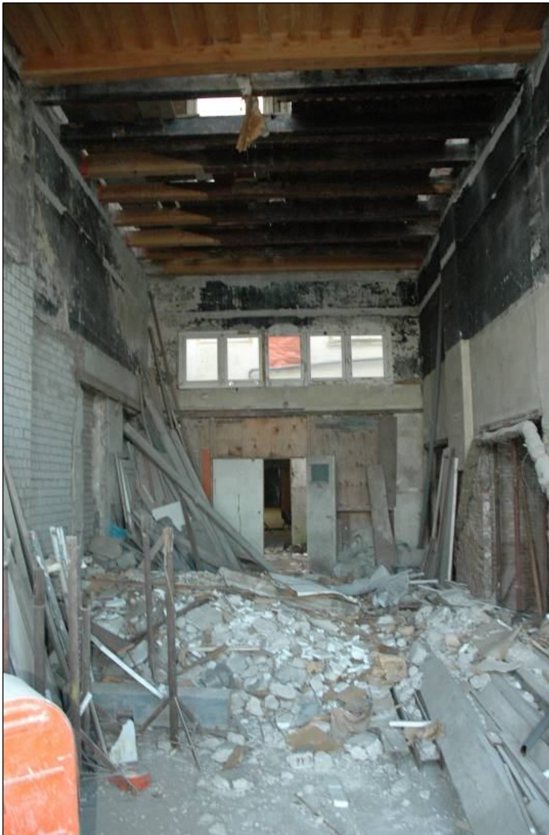
Afb. 23: Ruimte 0.10, gezien naar voor. Bovenaan de foto is het gereconstrueerde moer- en kinderbinten-plafond te zien.
