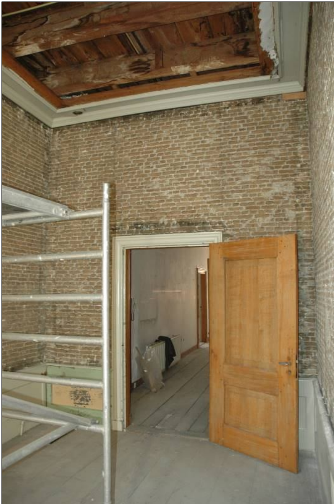
Afb. 29: Ruimte 1.01, het voorvertrek waarop de middengang eindigt. Aan het omlopende metselwerk is te zien dat dit vertrek in één keer tot stand kwam. Inclusief betimmering en paneeldeur zien we hier dus nog een 18de-eeuwse situatie.
