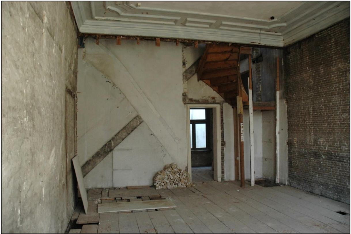
Afb. 31: Ruimte 1.04, het vertrek rechtsvoor op de verdieping, gezien naar achter. Het laatste gedeelte is een in latere instantie bij het voorvertrek getrokken dwarsgelegen trappenhuisje. Tegen de achtermuur tekenen zich twee trappen af, in elkaars tegengestelde richting. Meer recent werd er een trap rechts vanuit het achtergelegen vertrekje (1.05) gemaakt. Het is niet uitgesloten dat het bovenste stuk daarvan het verplaatste restant is van de oude trap die zich links op de achterwand aftekent.
