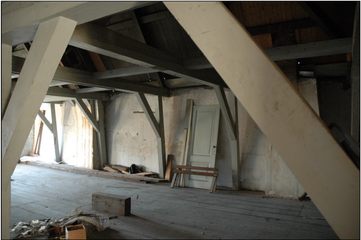
Afb. 39: Ruimte 2.01 - 2.02, overzicht over de voorzolder links, naar linksvoor.
