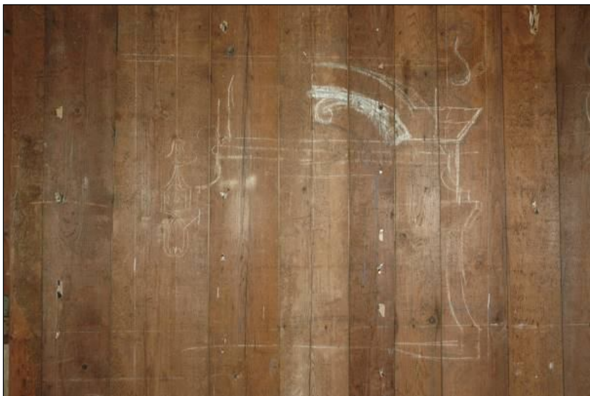
Afb. 34: Ruimte 1.07 met op de achterwand een geschetst voorbeeld van hoe het in 3D in de nabijheid als snijwerk uitgevoerd moest worden, Hoogstwaarschijnlijk 19de-eeuws.
