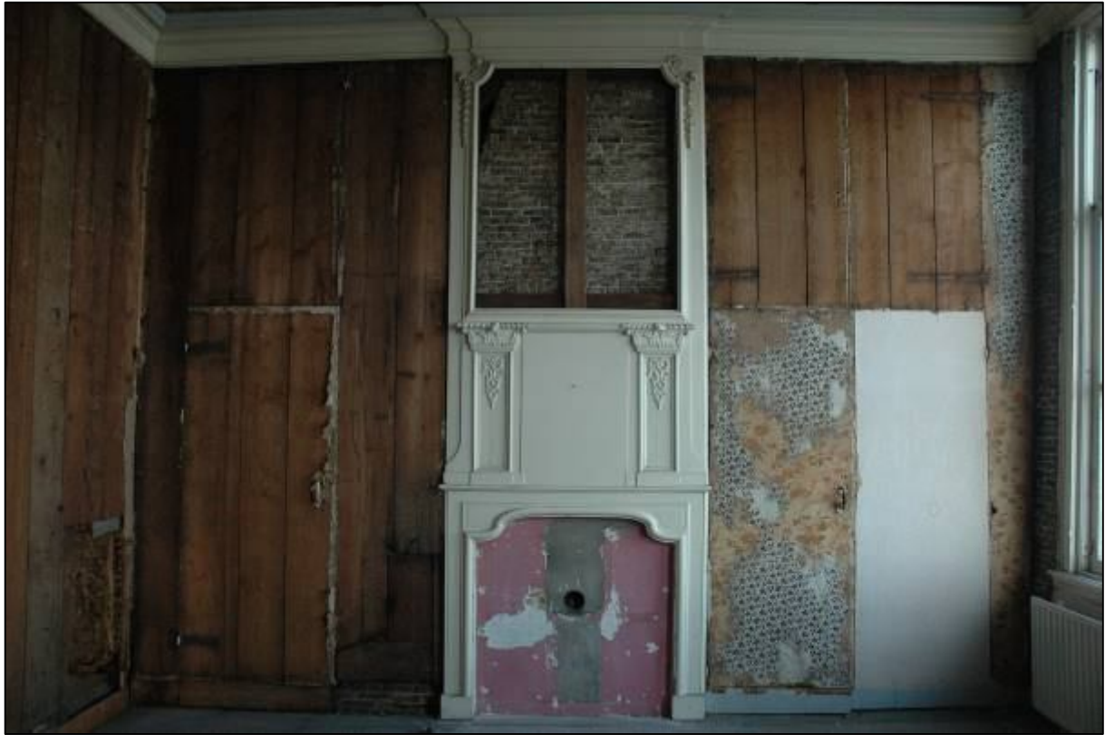
Afb. 35: Ruimte 1.08, in de richting van de linker bouwmuur.
