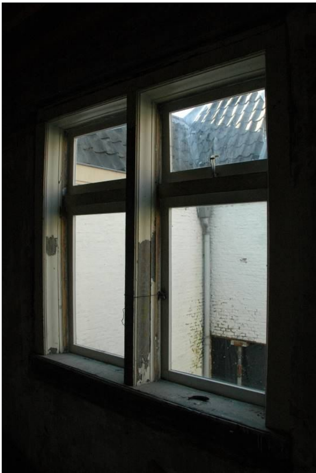
Afb. 38: Ruimte 2.03, het restant van een vermoedelijk 17de-eeuwse kruisvenster in de binnenplaatsgevel.
