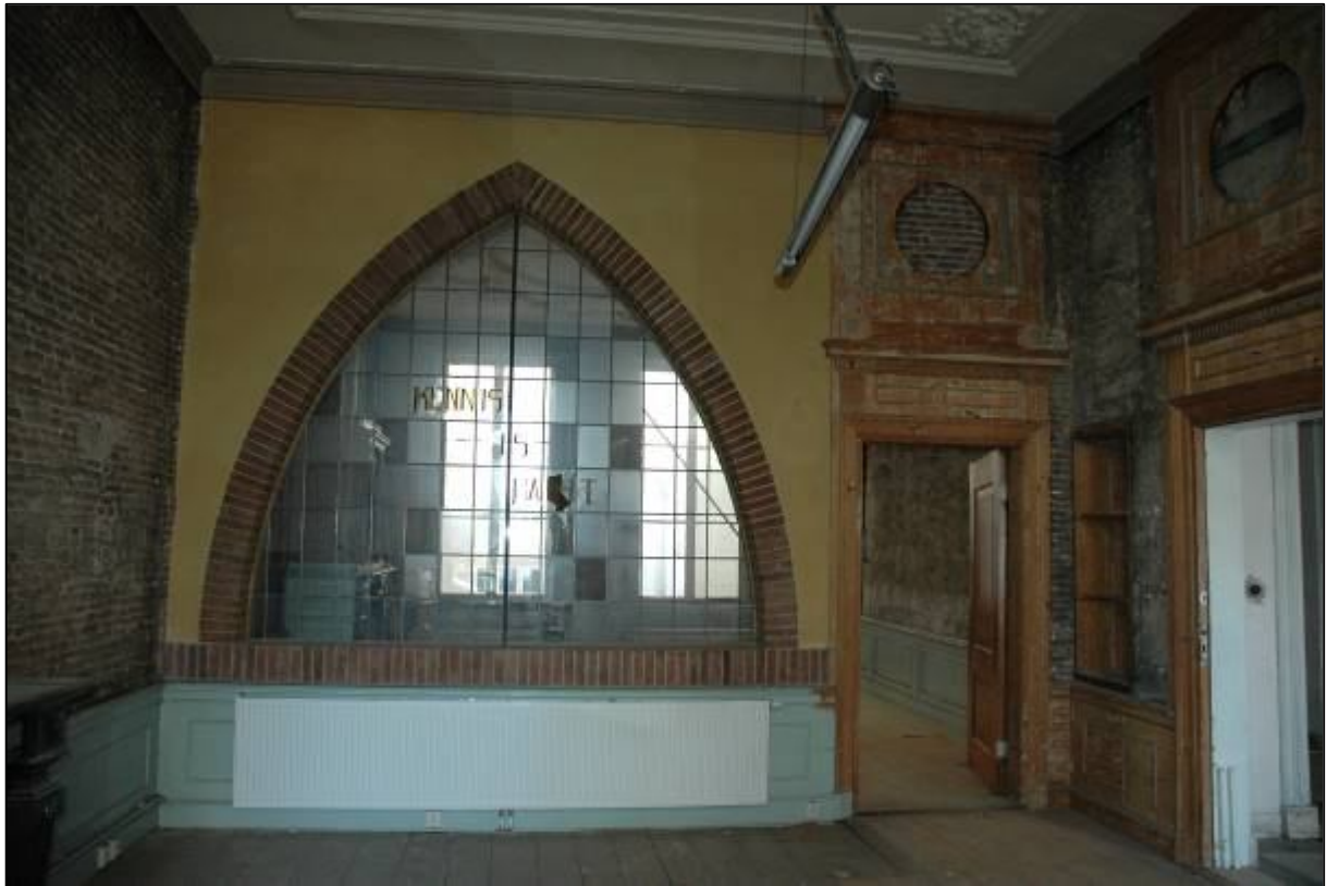
Afb. 13: Ruimte 0.02, de spitsboog (1949? In samenhang met onderwijs aangbracht?) in de achterwand. Rechts ervan ziet men de deuren met betimmeringen en omlijsting van bovendeurstukken ('dessus de porte').
