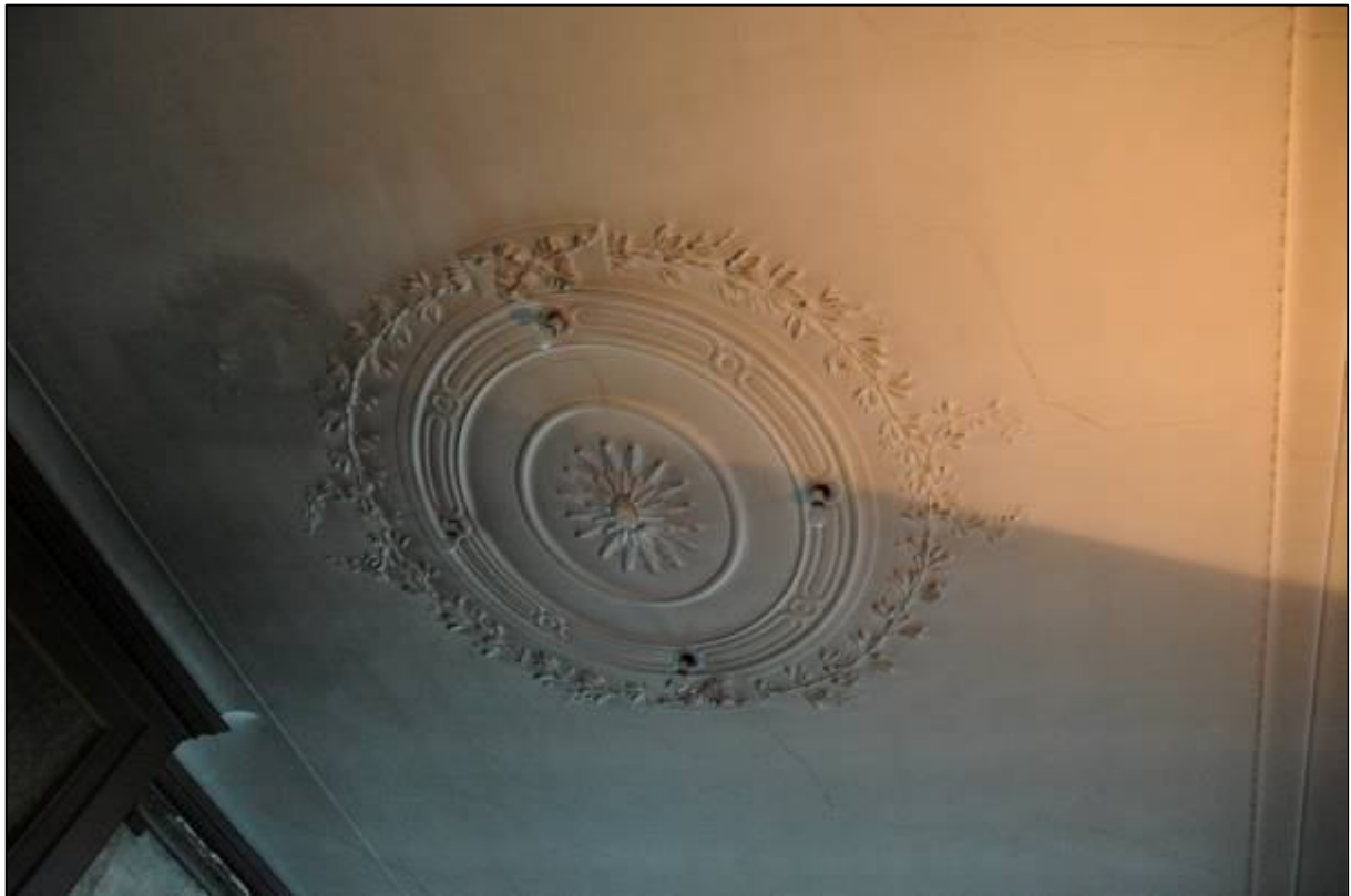
Afb. 19: Ruimte 0.07. Het middenrozet van het stucplafond heeft een eenvoudige doch verfijnde neo-empire-vormgeving.
