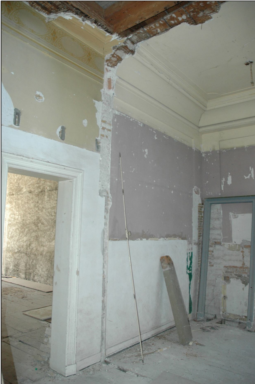
Afb. 32: Ruimte 1.05, gezien naar linksvoor. In 1908 werd van een achtervertrek een gedeelte afgescheiden dat meteen naar rechts werd vergroot met een doorbraak van de met het buurpand gedeelde bouwmuur. De 19de-eeuwse kooflijst (later achter een plafond verstopt en merk ook de nissen op!) en de nieuwere lijst met sjabloonrand getuigen van deze fasering.
