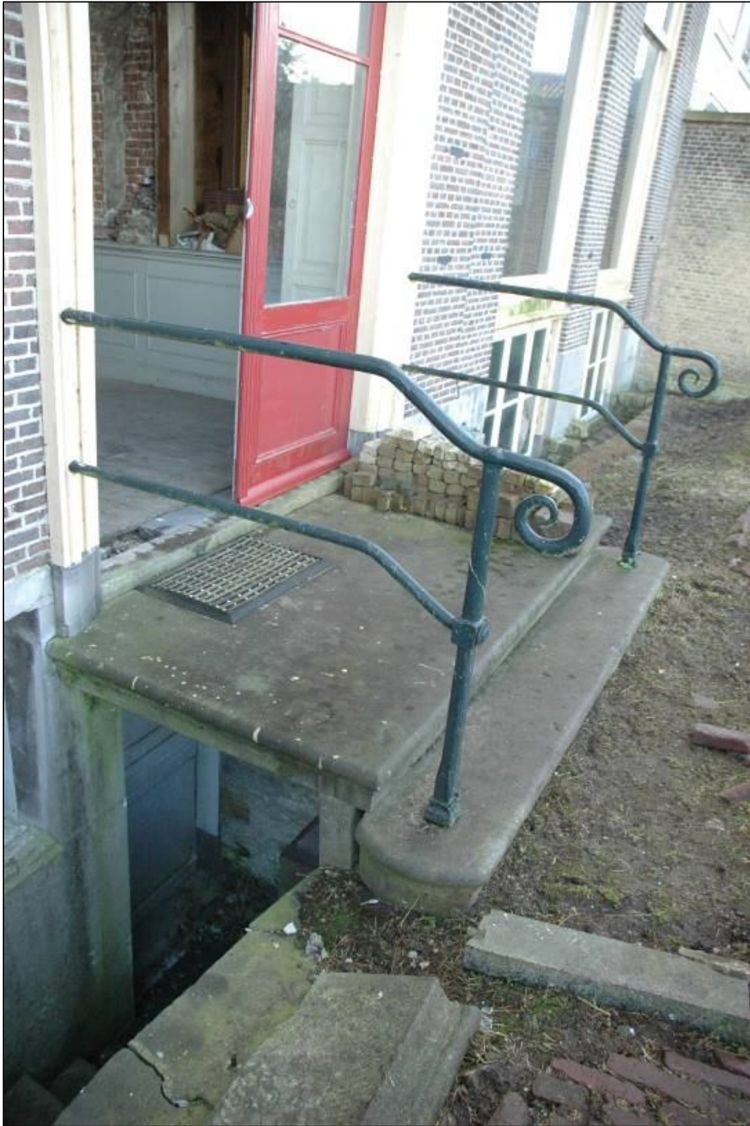
Afb. 6: Stoepje tegen de achtergevel met eronder de keldertoegang. De foto geeft er iets van weer, zij het niet alles: de stoep en de elementen die deze omgeven bestaan uit hardstenen elementen uit meerdere periodes. Het hier getoonde hekwerkje laat net als de kelderdeur zien, dat deze entrees meer dan eens zijn aangepakt – al staat buiten kijf dat de doorgangen zelf er sinds de 18de eeuw zitten.
