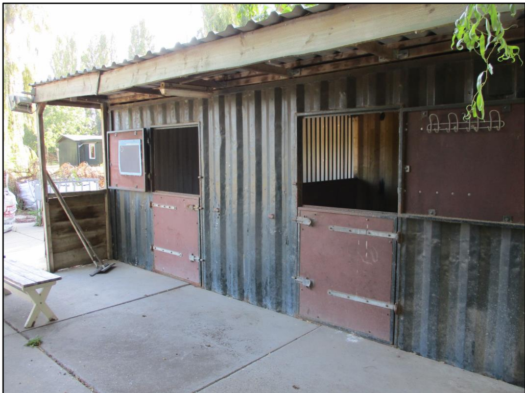
Figuur 4 Een van de zeecontainers welke is omgebouwd tot paardenstalling op de planlocatie.
