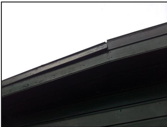
Foto 7: Opening in daklijst aan oostzijde woning
