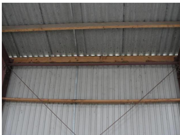
Figuur 6. Het dak bestaat uit golfplaten die rusten op houten balken. Tussen de golfplaten en de balk is steeds een ruimte, die groot genoeg is voor een Huismus of vleermuis om door te kunnen.
