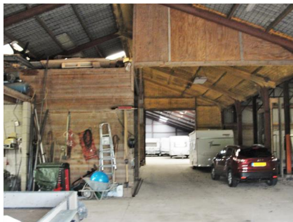
Figuur 5. Houten inbouw met werkplaats.
