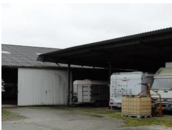
Figuur 4. Eén van de loodsen en het afdakje, gezien van opzij.
