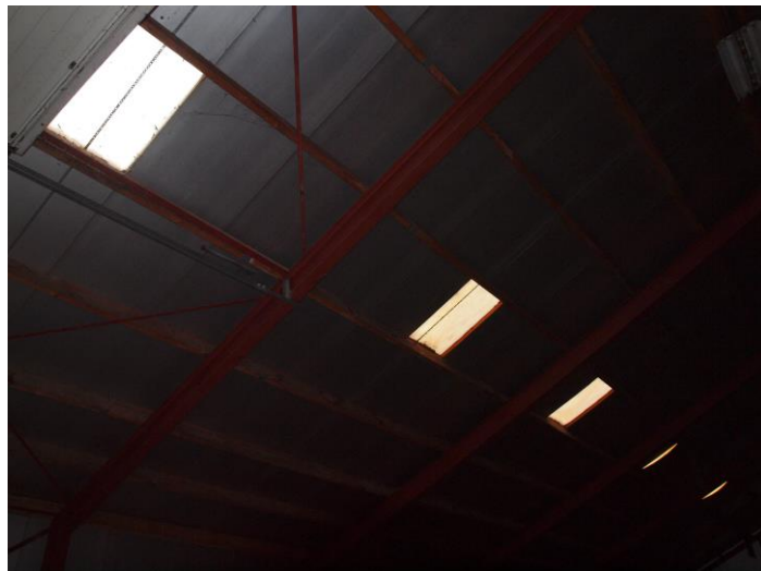
Figuur 5. De dakplaten worden direct ondersteund door balken (zonder dakbeschoot).
