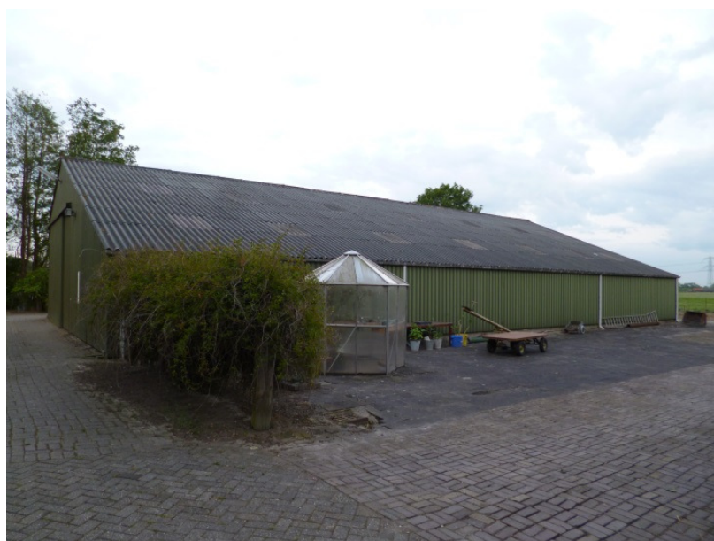
Figuur 5: De meeste opstallen bestaan uit damwandprofielen en golfplaten
