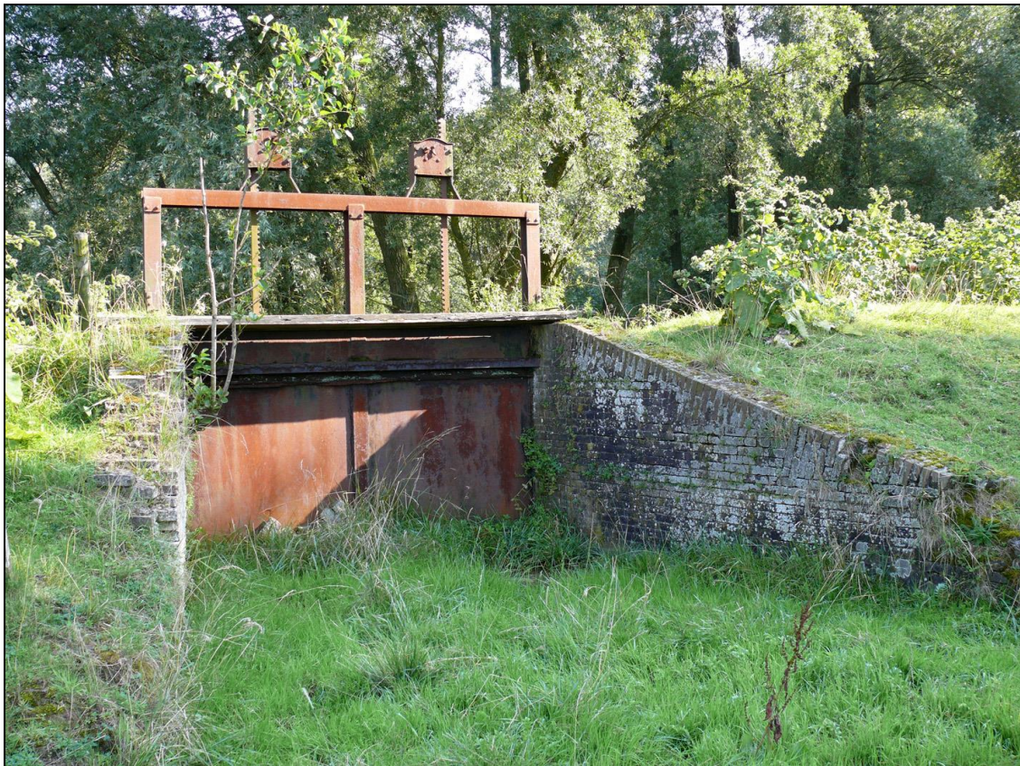
Hevelsluis of 'ijzeren man' in Polder Stedelijk
