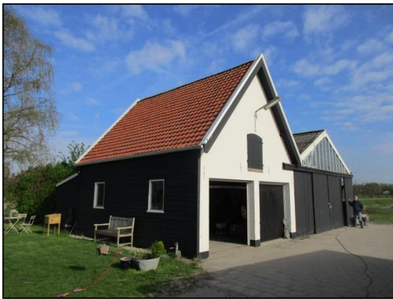
Foto 1: Te slopen bijgebouw in plangebied
