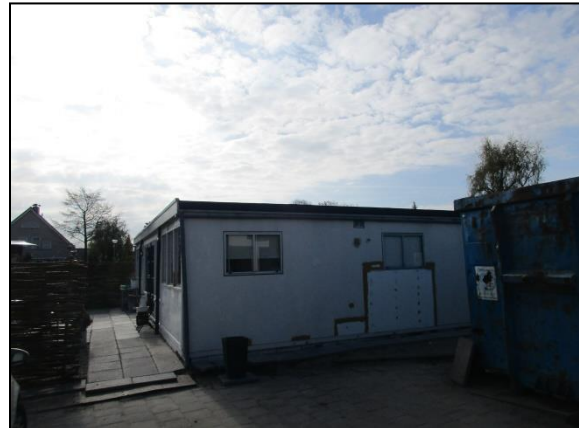
Foto 4: Tijdelijke woning in plangebied
