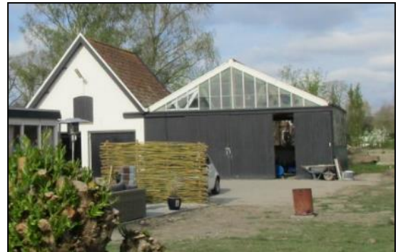
Foto 6: Te slopen bijgebouw, noordelijk in plangebied
