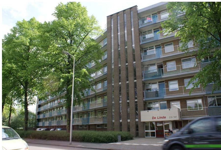
Horizontale geleding met vertikaal accent bij ingangspartij/trappenhuis ▲
