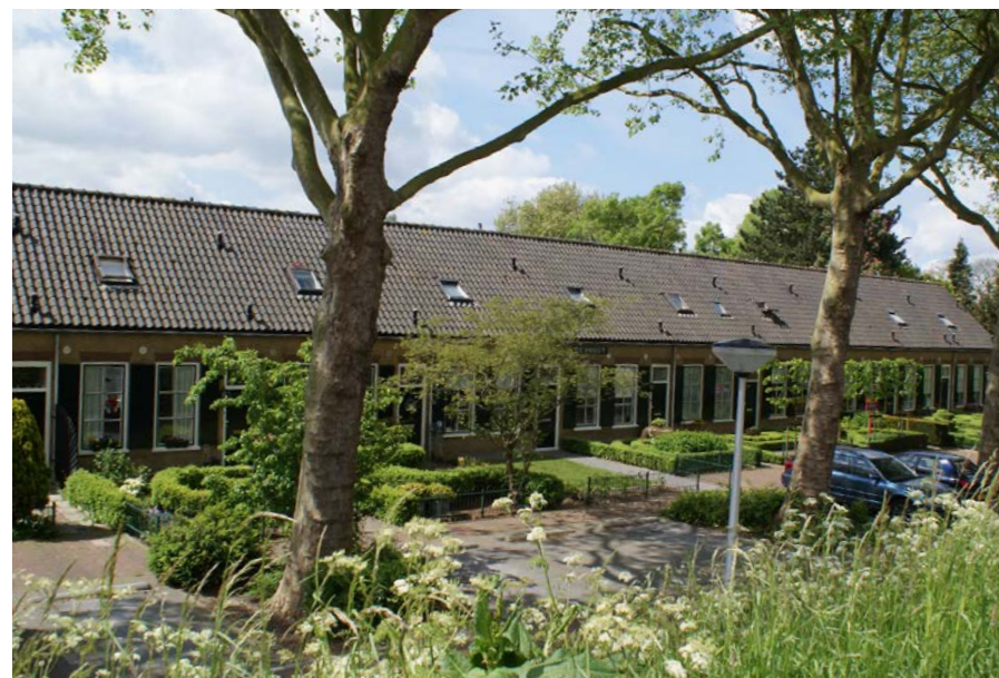
Monumentale panden vormen verbijzonderingen in het lint ▲
