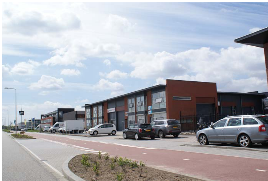
Representatieve kantoren/showrooms aan de voorzijde, bedrijfshal erachter ▲
