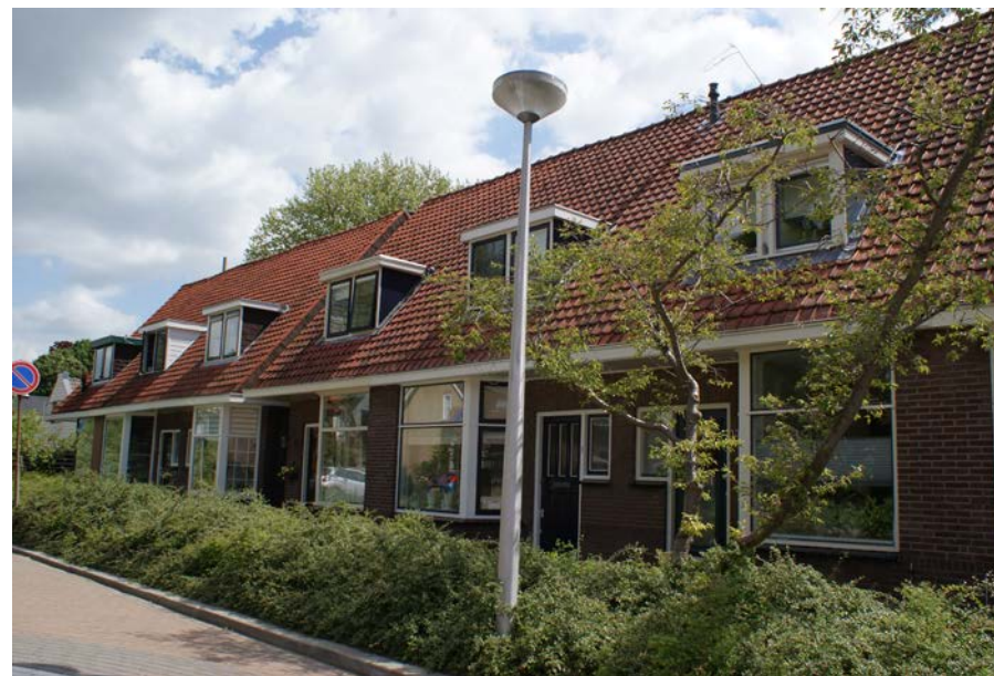
Uitkragende dakgoot benadrukt horizontale geleding ▲
