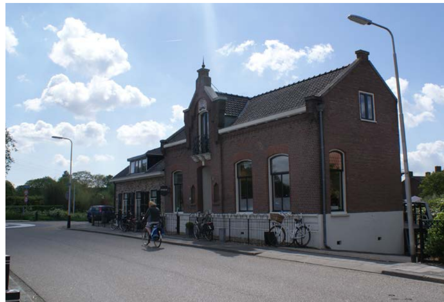
Monumentale panden vormen verbijzonderingen in het lint ▲
