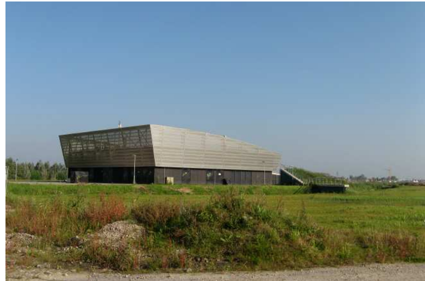
Schachtgebouw van de Betuwelijn in De Volgerlanden
