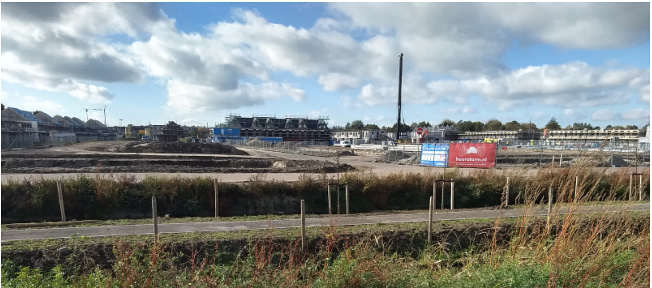
Overzicht deelgebied C1 met bouwwerkzaamheden op grote schaal.
