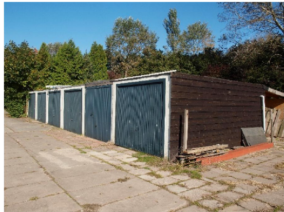
Figuur 2: Overzicht op de garageboxen in het projectgebied vanuit oostelijke richting
