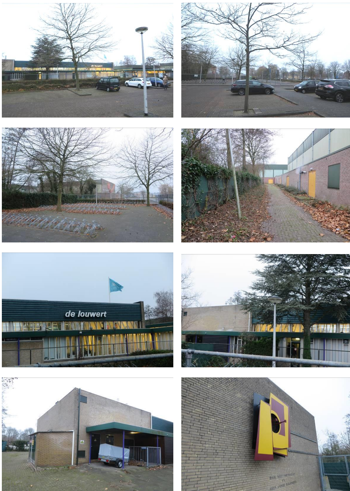
Figuur 2. Aanzicht van de bebouwing en entreegebied van Zwembad de Louwert te Hendrik Ido Ambacht (te reconstrueren / slopen).
