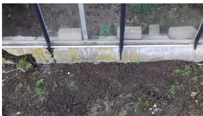
foto 36 - betonrand bij inspectiegat IG07
