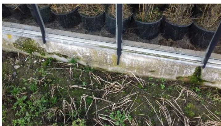
foto 35- betonrand bij inspectiegat IG06
