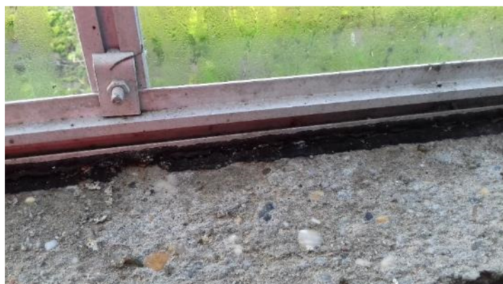
foto 32- bitumenrand bij inspectiegat IG01
