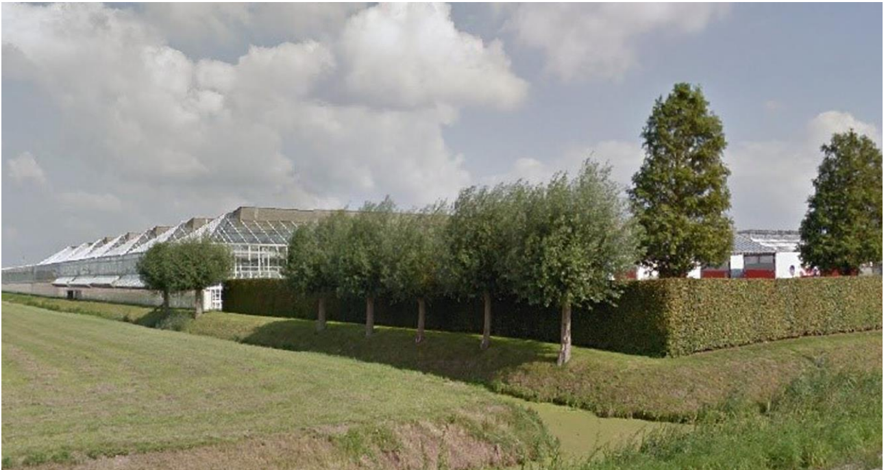
Foto bestaande situatie (Google streetview)
