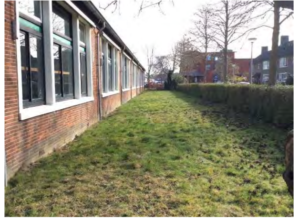
Fotonummer 4: Zuidzijde onderzoekslocatie.
