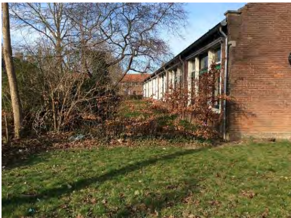
Fotonummer 5: Oostzijde onderzoekslocatie.
