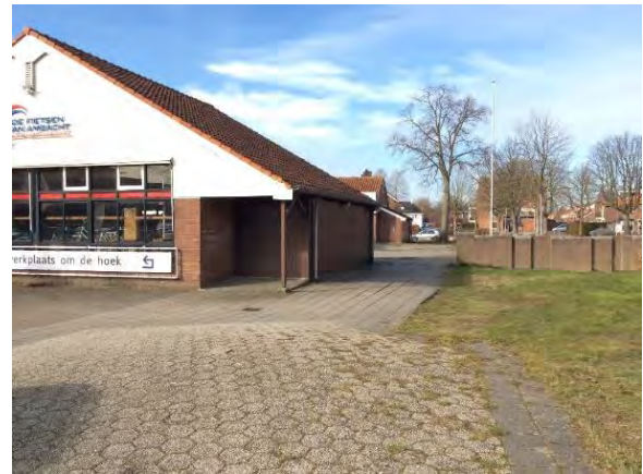
Fotonummer 8: Oostzijde onderzoekslocatie.
