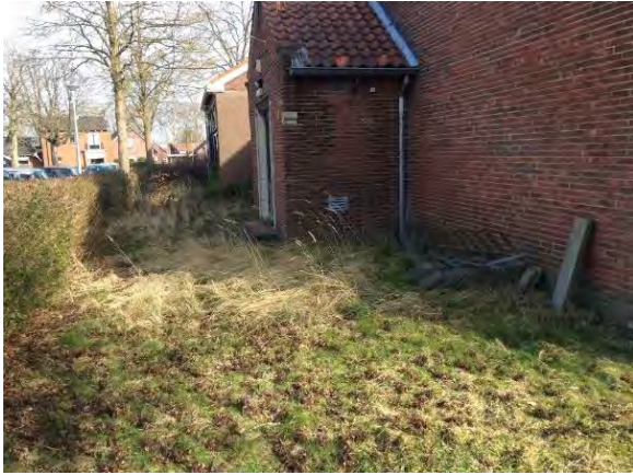
Fotonummer 1: Zuidzijde onderzoekslocatie.
