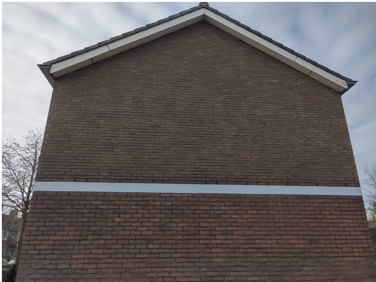
Op enkele plaatsen zijn open stootvoegen in de gevels aanwezig. Foto: K.C. Fokker | Ecoresult B.V.
