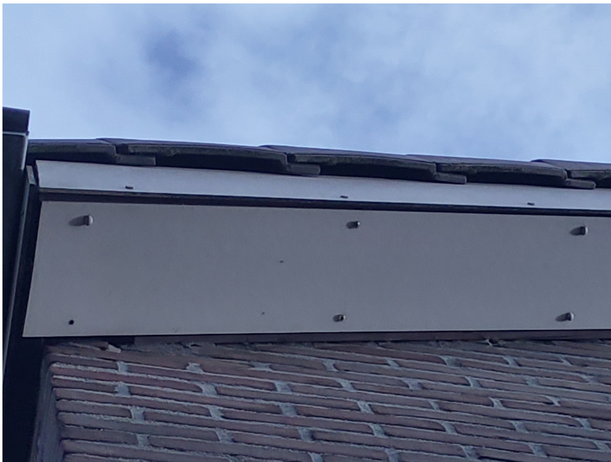
Op de kopse gevels is ruimte onder de dakpannen aanwezig. Foto: K.C. Fokker | Ecoresult B.V.
