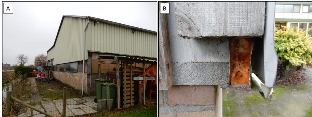
Figuur 4 Fotografische indruk van de loods en gevelafwerking met metalen damwandplaten. (A) de loods is opgebouwd uit stenen muren van ongeveer 1 m hoogte. Hierboven is de loods opgebouwd uit metalen damwandplaten. (B) aan de achterzijde van de metalen damwandplaten zijn voorgeïsoleerde platen bevestigd.
