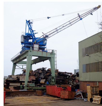
Kraan in bestaande context
