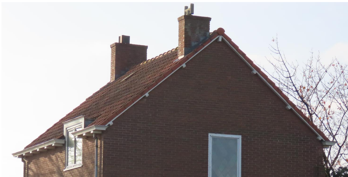
Figuur 5-2: Gevel en dak Veersedijk 253
